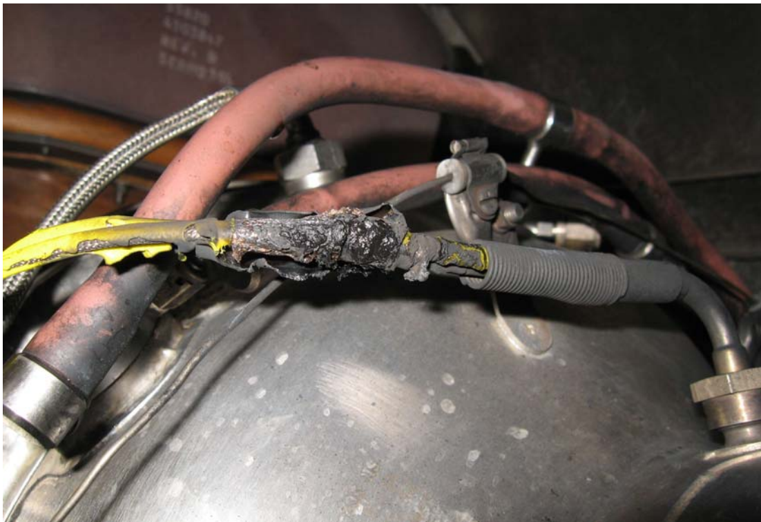
Kuva 3. EGT-anturin sähköjohto ja paloilmalanka
