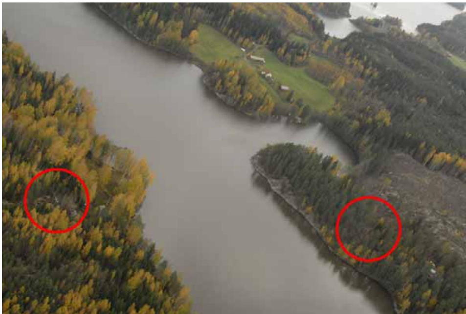
Kuva 4. 20 kV voimajohto ja onnettomuuspaikka ilmasta kuvattuna 17.10.2006 noin 200 m korkeudelta. Voimajohtoa kannattelevat pylväät ympyröity.
