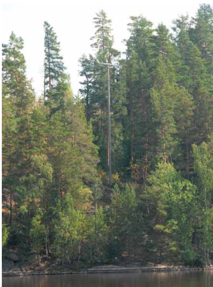
Kuva 2. Itäpuolinen voimajohtoa kannatteleva pylväs.
