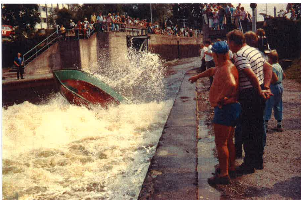
Rekonstruktion aikana 13.07.1988 otettu kuva, jossa vene (ei onnettomuuteen joutunut vene) syöksyy täyden juoksutuksen aikana sulun avoimen alaportin läpi alakanavaan syntyviin kuohuihin.
