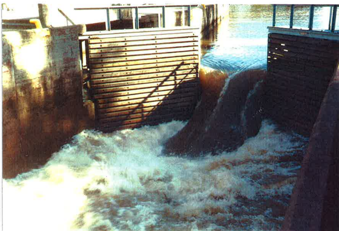
Veden juoksutusta osittain avatun ylemmän sulkuportin läpi
