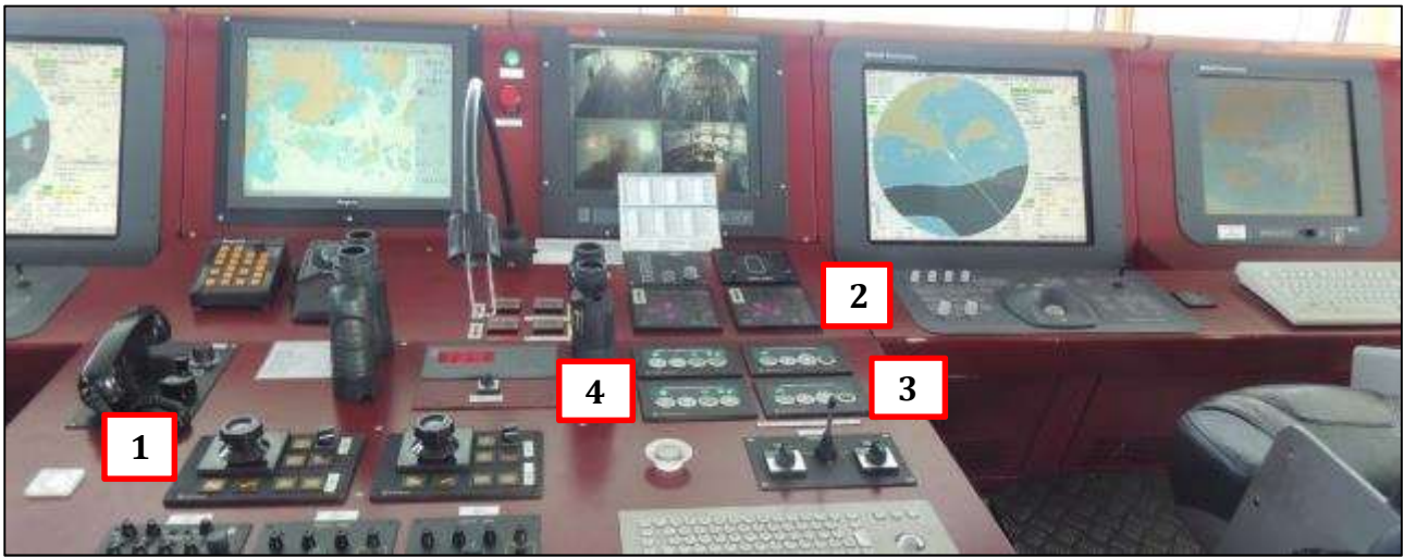
Kuva 14. Komentosillan perän suunnan ohjauspisteen varaohjauspaneelit (1), ruoripotkureiden asetonäytöt (2), tehonsäädön ohjaustavan, kuormitusrajoituksen ohituksen ja automaattiohjauksen ohjauspaneelit (3) sekä ohjauspaikan valinnan ja ruoripotkureiden kytkinten ohjauspaneelit (4). (Kuva: OTKES)
