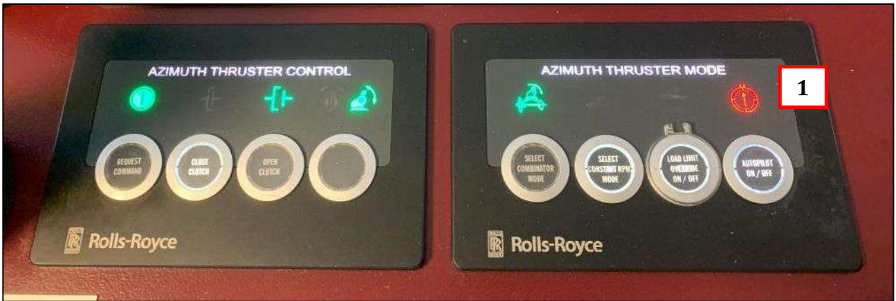
Kuva 19. Ohjauspisteen painonappipaneelit simuloidussa tilassa, jossa automaattiohjaus on ollut kytkettynä ja ruoripotkurin ohjaus on vikaantunut. Punainen merkkivalo (1) ilmaisee vikatilaa. (Kuva: OTKES)
