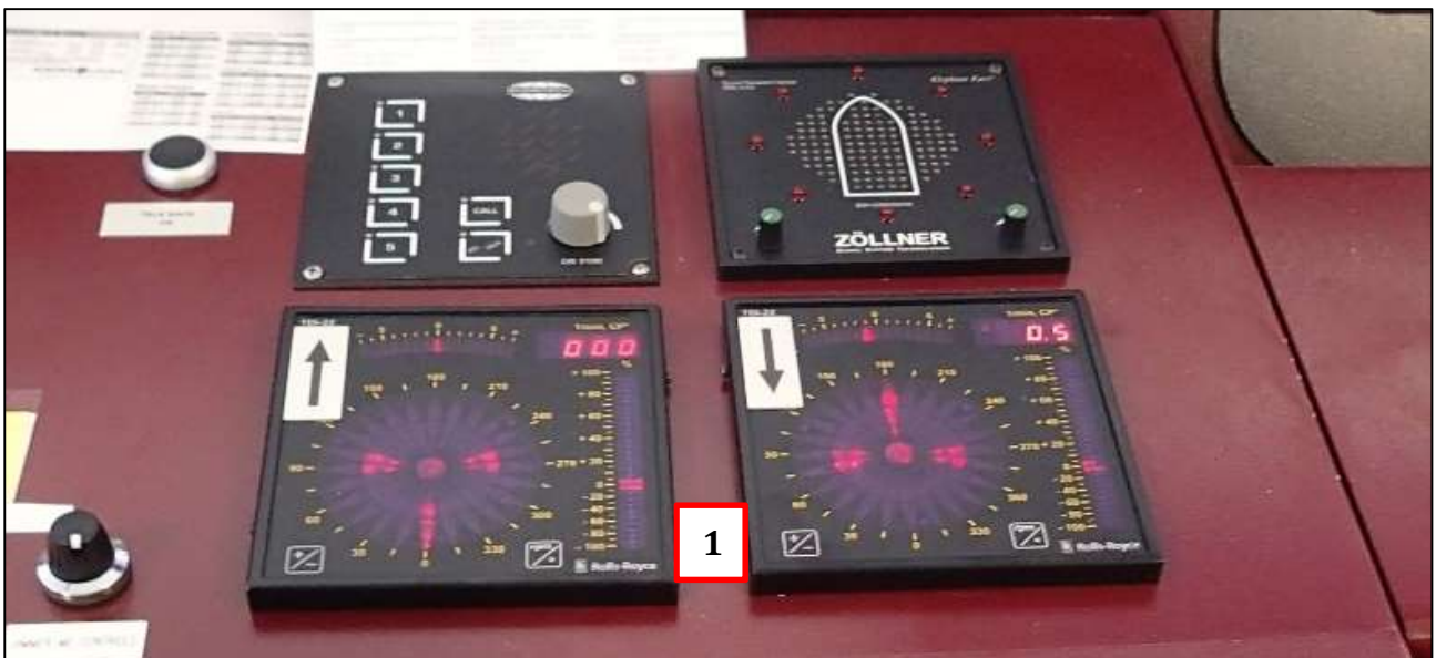
Kuva 20. Komentosillan ohjauspisteen ruoripotkureiden asetonäytöt (1). Vasemmanpuoleisessa asetonäytössä on kulkusuunnassa etummaisena ja oikeanpuoleisessa taemman ruoripotkurin tila. (Kuva: OTKES)
