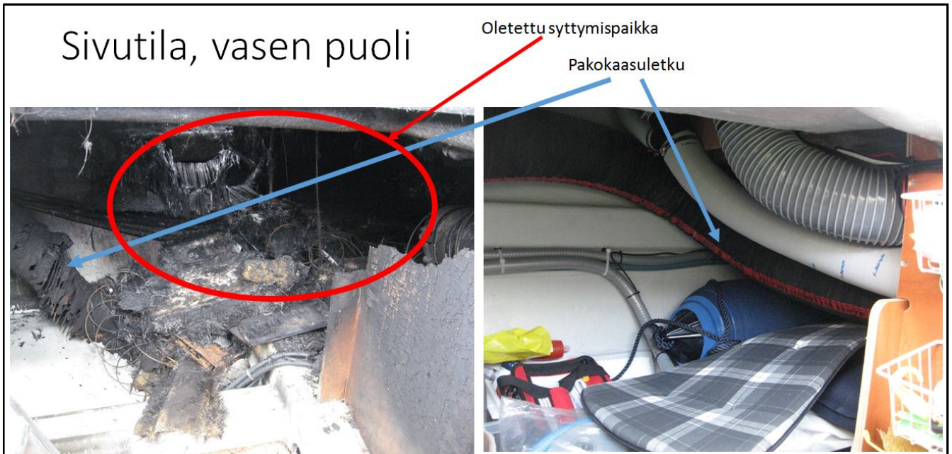
Kuva 3. Tulipalon todennäköinen syttymispaikka on vasemman puolen sivutilan takaosassa. Oikeanpuoleinen kuva on vastaavasta veneestä samasta paikasta. (Kuvat: OTKES)
