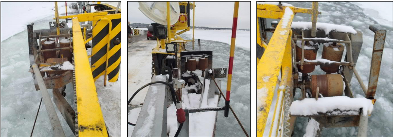
Kuva 13. Rullat, joiden kautta ohjausvaijeri kulkee lossin kyljellä. Kuvasaikaan vaijeri ei ollut kytkettyä lossiin johtuen jääolosuhteista. Onnettomuuden tapahtuessa ei ollut jäitä. (Kuvat: Onnettomuustutkintakeskus)
