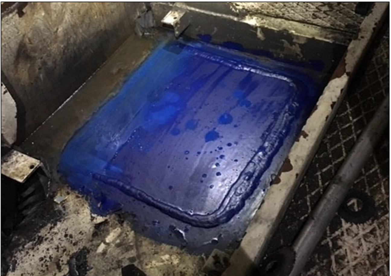
Kuva 8. Telakalla asennettu korjauslevy. (Kuva: Liikenne- ja viestintävirasto)
