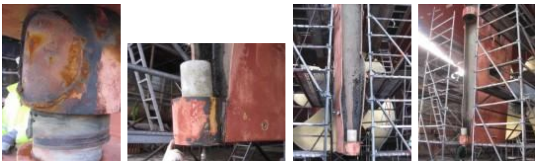
Kuvat 9, 10, 11 ja 12. Peräsinvaurioita kuvattuna korjaustelakalla. (Kuvat: DNV GL)
