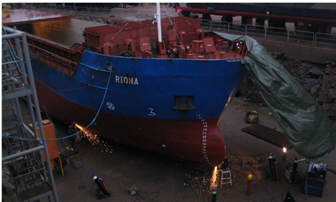
Kuva 10. Kuva telakoinnissa. Vauriokohdat leikattavina. (Kuva: OTKES)
