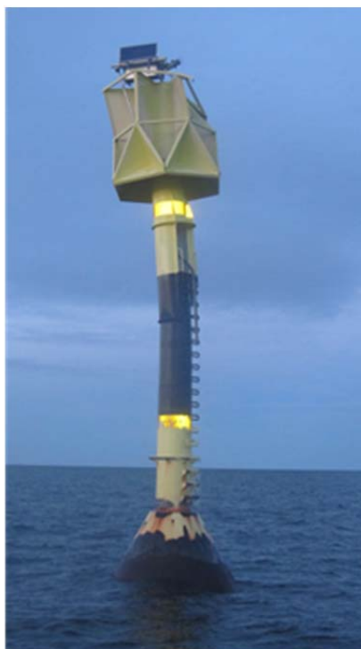
Kuva 9. Vaurioitunut Holman reunamerkki. (kuva: Liikennevirasto)
