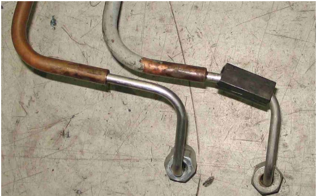
Kuva 16. Pääkoneen sylintereihin johtavat polttoaineen ruiskutusputket. Putkien kaksoisrakenne on näkyvissä. Kuparinen vaippaputki ei ulotu päähän saakka. Kuvan 17a valokuvassa, jossa putket ovat puhdistettuina koneen korjaajan verstaalla, on sormin osoitettu vuotokohta.
