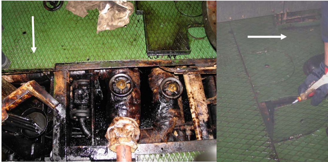
Kuva 16c. Viskosimetrin venttiilien alue. Vasemmalla turkkilevyt avattuina 17.12.2013, oikealla niitä avataan 20.12.2013. Vasemman venttiilin (huollossa olleen viskosimetrin) kara oli poikki, irronnut kara näkyy kuvan ylä laidassa. Kuvassa keulasuunta on näytetty nuolella.
