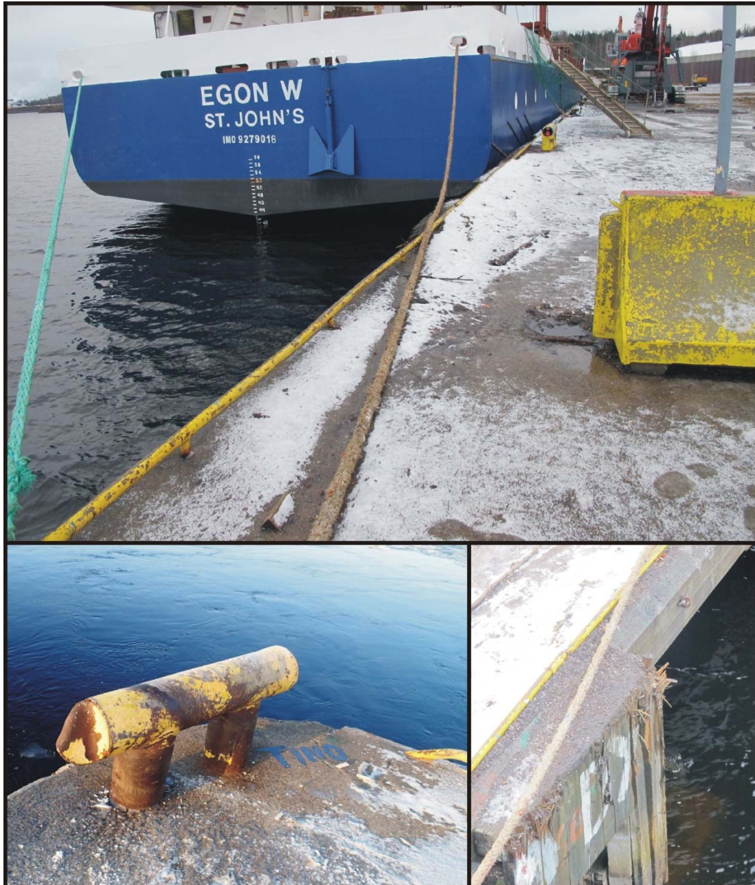
Kuva 15. Laiturikannen reuna-alueilla oli onnettomuuden jälkeisenä päivänä havaittavissa liikkumisen ja työskentelyn riskiä lisäävää puujätettä (ylin kuva). Myös laiturin kulman kiinnityspollarissa oli saumasta auki repeytynyt ja vääntynyt päätälaippa sekä laiturin suojararruissa puusäleitä, jotka molemmat voivat vaikeuttaa köysityöskentelyä. (kuvat: poliisi, Otkes)
