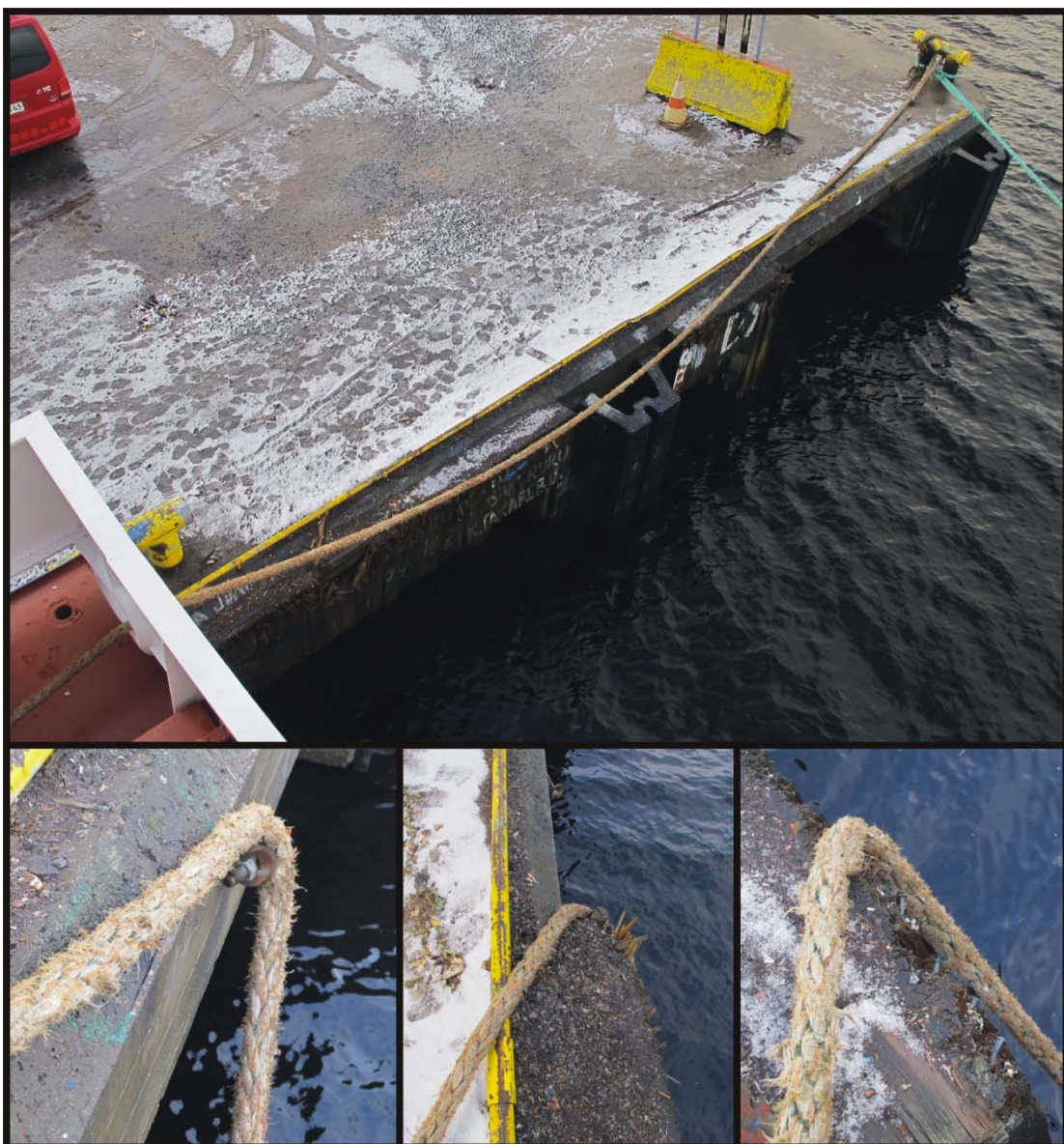
Kuva 9. Laiturin reunassa on useita kohtia, joihin köysi voi takertua kiinni. Kuvattu 27.11.2013 (kuvat: poliisi)
