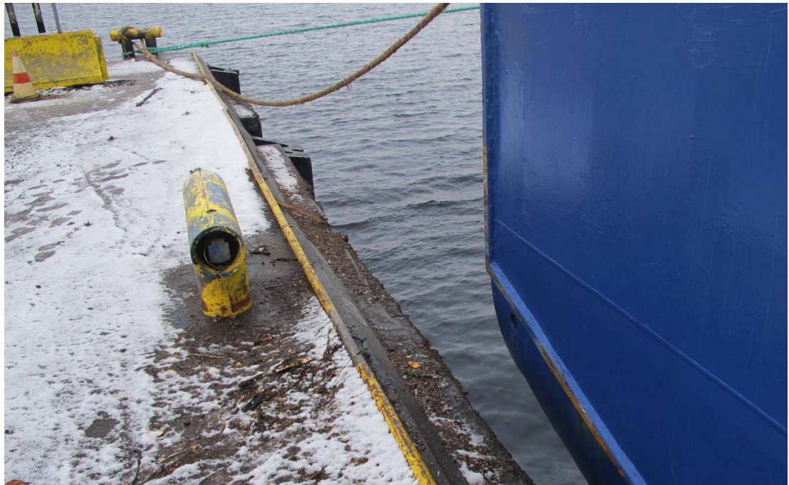
Kuva 4. Betoninen laiturikansi onnettomuuspaikalla, B-laiturin länsipäässä. Kuvassa näkyy keltainen metalliputkesta valmistettu reunaeste ja EGON W:n tyyrpuurin peräkulma sekä laiturin reunassa olevat puiset suojaparrut. Kuva otettu 27.11.2013. (kuva: poliisi)
