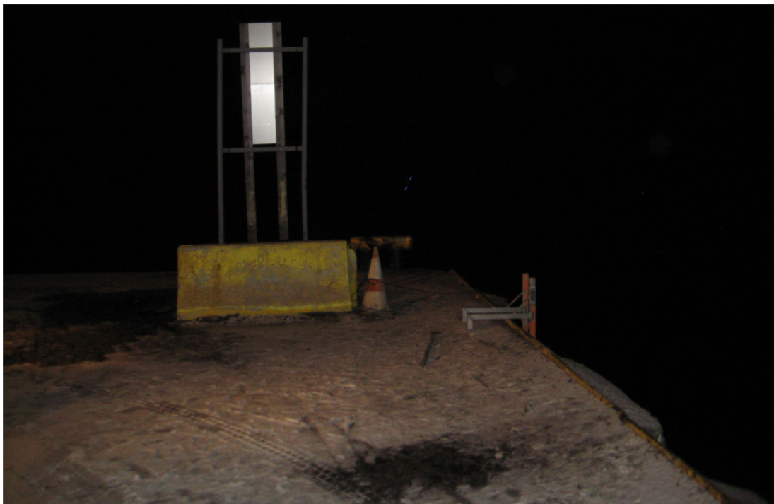
Kuva 5. Kuva onnettomuuskohdasta 26.11.2013. Infotaulun betonijalustan ja sen vieressä pinottuna olleiden huomiokartioiden takia kulkutie laiturin reunalla oli varsin kapea. Kuvassa laiturin reunalla näkyvät tikkaat on tuotu paikalle pelastustoiminnan aikana. (kuva: Stora Enson tehdaspalokunta)
