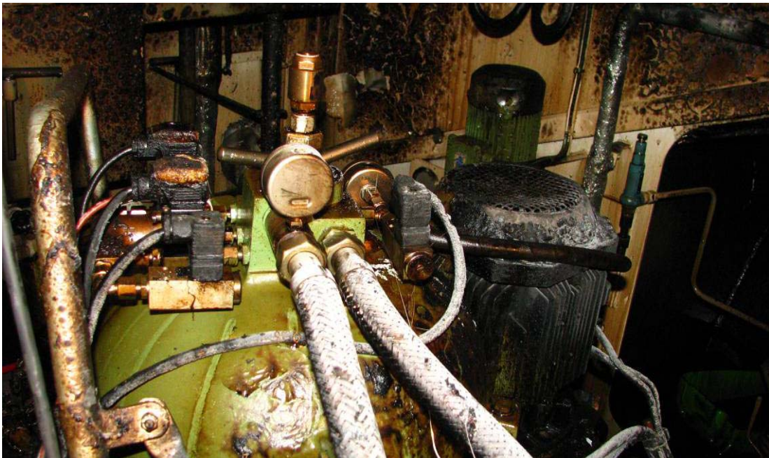
Kuva 9. Palovaurioita konehuoneen laitteissa.
