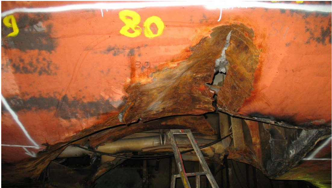
Kuva 8. Aluksen saamia vaurioita; repeämä oikean puolen painolastitankissa.
