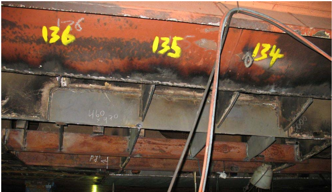
Kuva 9. Aluksen saamia vaurioita; korjattu repeämä painolastitankissa vasemmalla.
