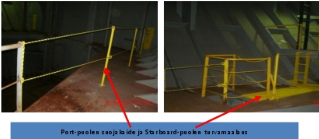
Kuva 6. Onnettomuuden jälkeen asennettu suojakaide vasemmalla ja oikealla huomiovärillä maalattu kulkutie.
