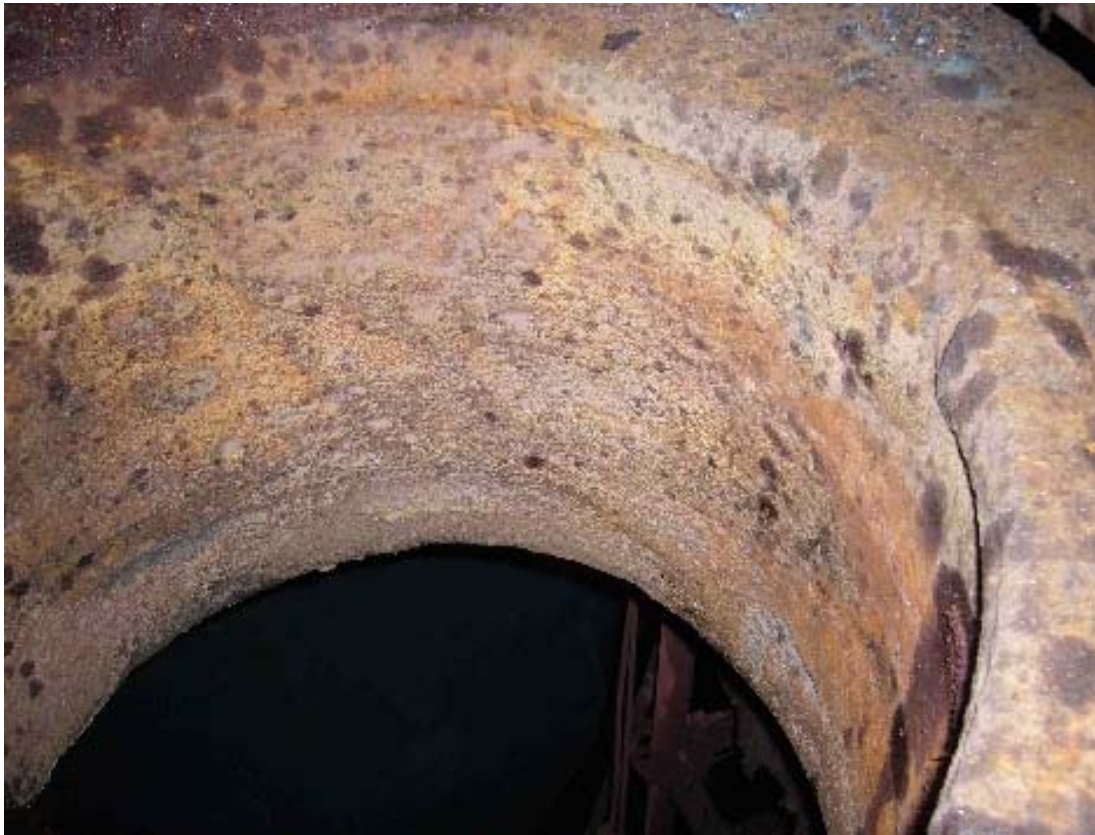
Kuva 43a. SB-puolen alalaakerin pesä ennen puhdistusta kuvattuna 3.12.
