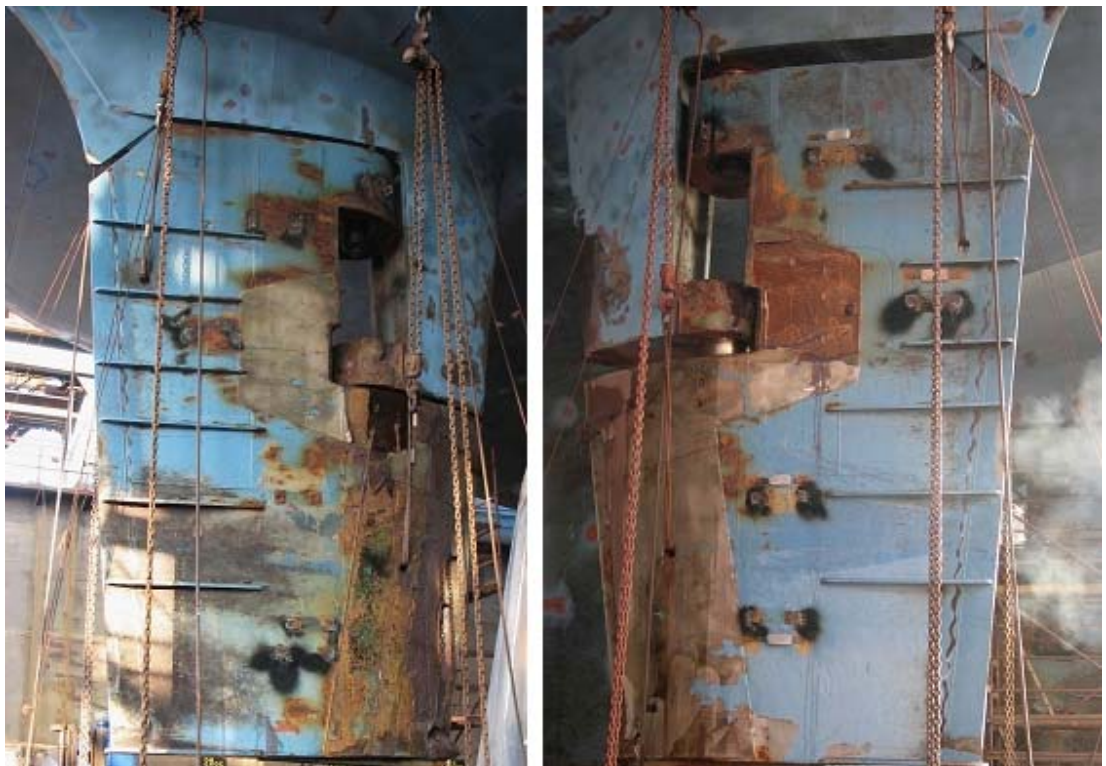
Kuva 24b. BB-peräsintä nostetaan Gdanskissa pois paikoiltaan 3.12. Vasemmalla on sisäpuoli ja oikealla ulkopuoli.
