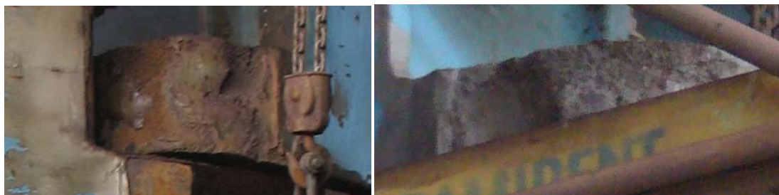
Kuva 24d. Peräsinsarven kavitaatiosyöpymiä. Vasemmalla BB (kuvattu 3.12), oikealla SB (Trafin kuva 4.12), molemmat keskilaivan puolella.
