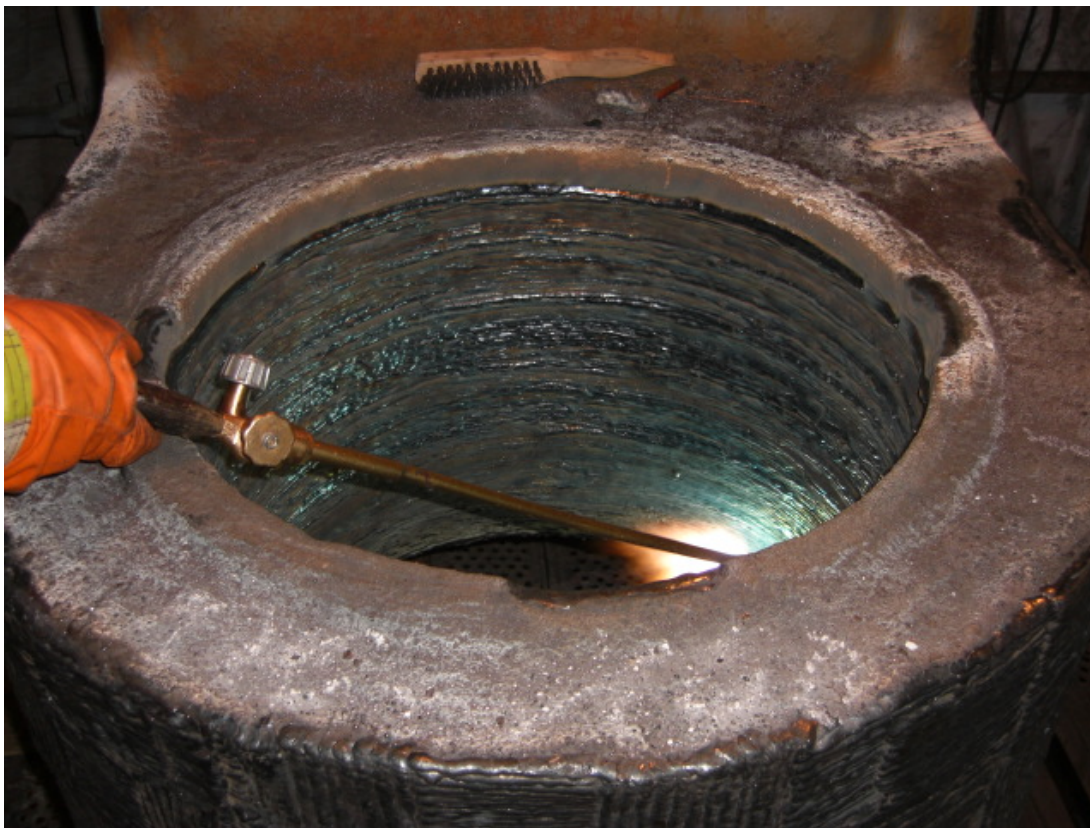
Kuva 29b. Alalaakerin BB-pesän korjausta päälle hitsaamalla. Osittain on näkyvissä pesän ulkopuolista päälle hitsausta, pysty- ja vaakasuuntaan hitsattuja alueita. Kuvattu 7.12, luokituslaitoksen kuva.
