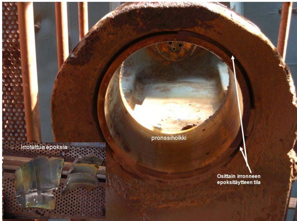
Kuva 44b. BB-alalaakeri peräsimen poiston jälkeen kuvattuna alhaalta. Kuvassa 44c laakeri on kuvattu ylhäältä. Kuvassa näkyy epoksitäytteen tilanne: sitä on irronnut paikoin 10–20 cm syvyydeltä. Pronssiholkin paksuus on noin 24 mm, joten epoksitäytteen paksuus on kuvan perusteella 15–20 mm. Pohjana Bureau Veritasin kuva johon on lisätty osa Trafin kuvasta (epoksi).
