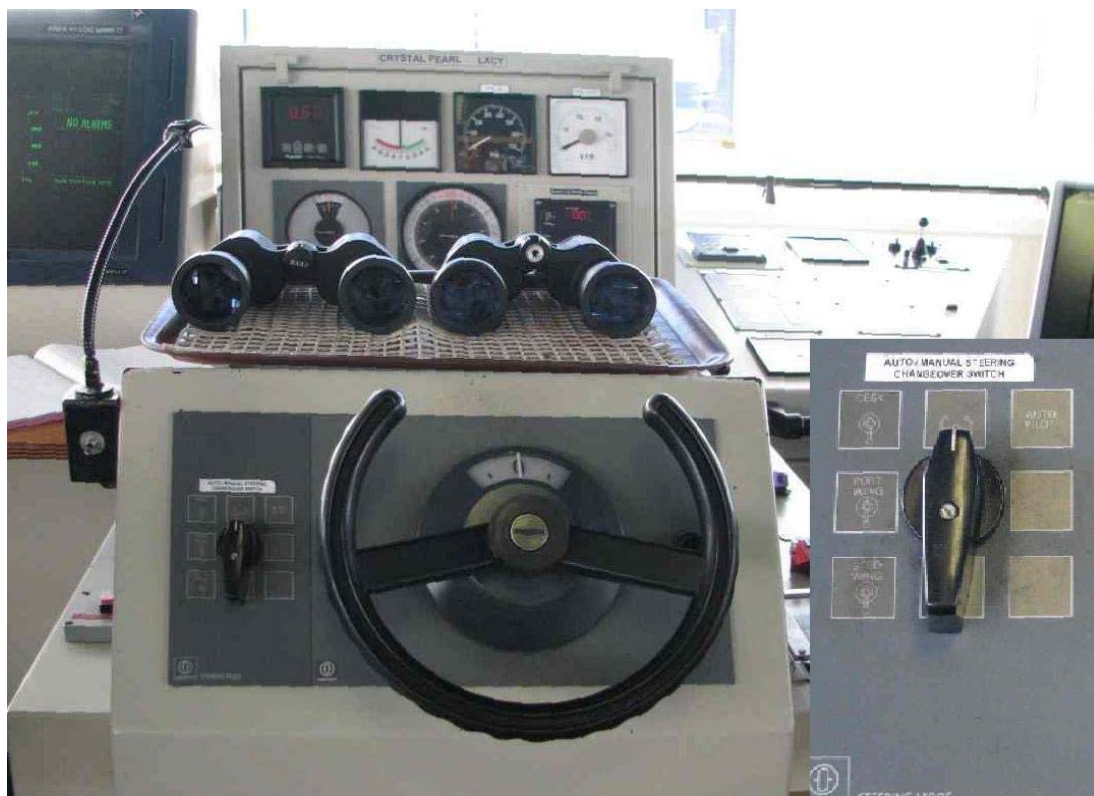
Kuva 5. Ruoripyyläs Follow-up käsiohjausta varten. Ohjailumuodon ja -paikan valintakytkin suurennettuna oikealla. Kuvassa kytkin on FU – käsiohjausasennossa. Oikealla ylhäällä automattiohjaimen valinta, vasemmalla ylhäällä keskikonsolin (desk) NFU -automaattiohjaus. Kaksi alinta asentoa vasemmalla osoittavat siipien NFU-ohjausta.
