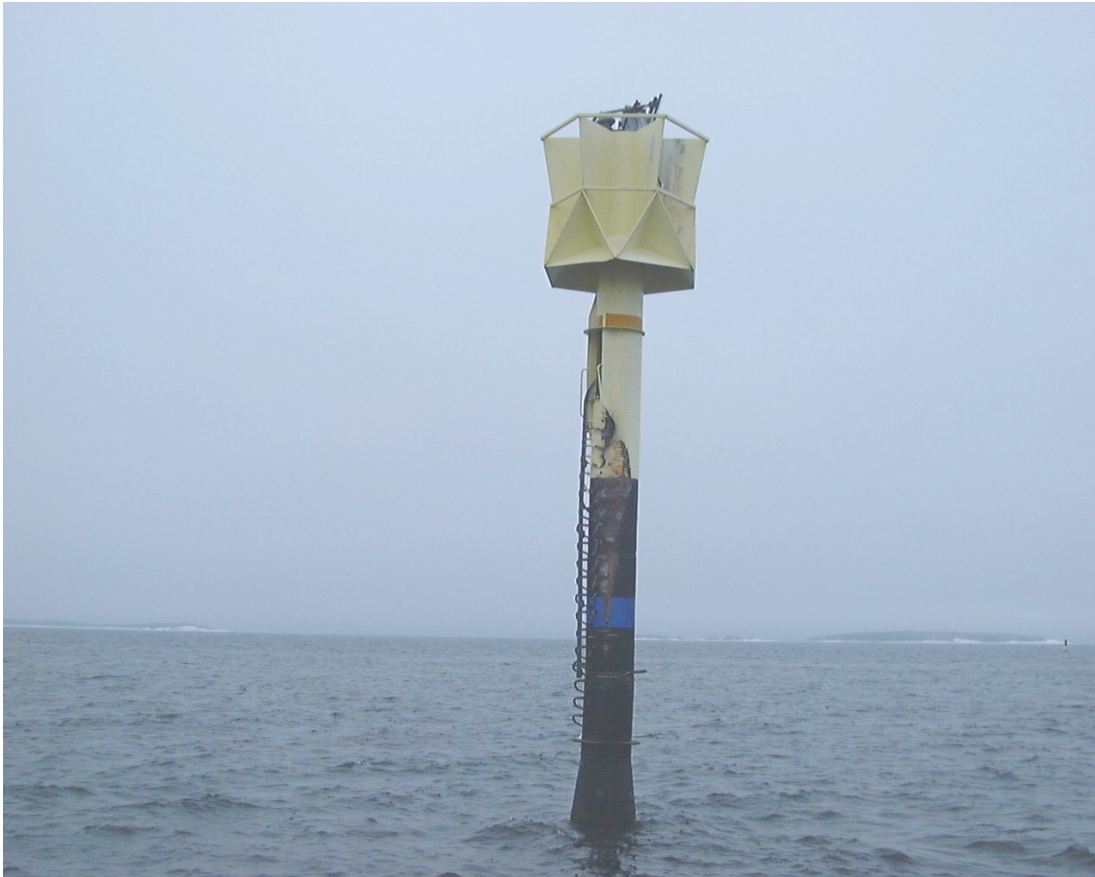
Kuva 9. Lålättan vaurioitunut reunamerkki.
