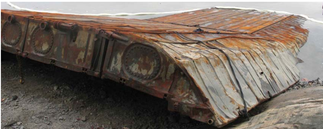
Kuva 13b Lautta vedettynä osittain maihin 11.6. Kuvassa on näkyvissä peräjakson vasemman sivuponttonin kaksi pitkää vahvikerautaa. Vasemman kyljen painaumat ovat selvästi näkyvissä. Reikä kyljessä on ankkurivaijeria varten. Taustalla kelluu öljyntorjuntapuomi.
