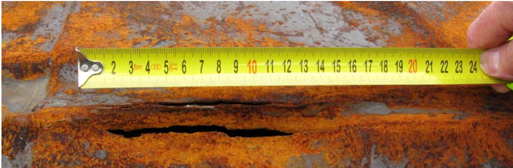
Kuva 7. Reikä F valokuvassa IMG 8906 11.6.
