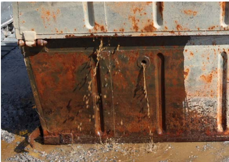
Kuva 10. Reikä I valokuvassa IMG 2315. Tämä ei ole reikä, josta tankkiin pääsee vettä.
