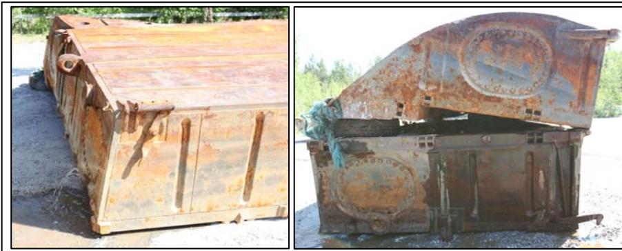
Kuva 14d. Kuvan 14c ponttoniyksikön peräpää, josta vuotaa vettä sen ollessa ylösalaisin, reikä C (vasen kuva). Oikealla yksikkö oikein päin sivuponttoni keskiponttonin päälle käännettynä. Kuvissa on paikoin näkyvissä yrityksen käyttämää sinistä maalia. Osia Kokkolan poliisin 29.6 ottamista kuvista.
