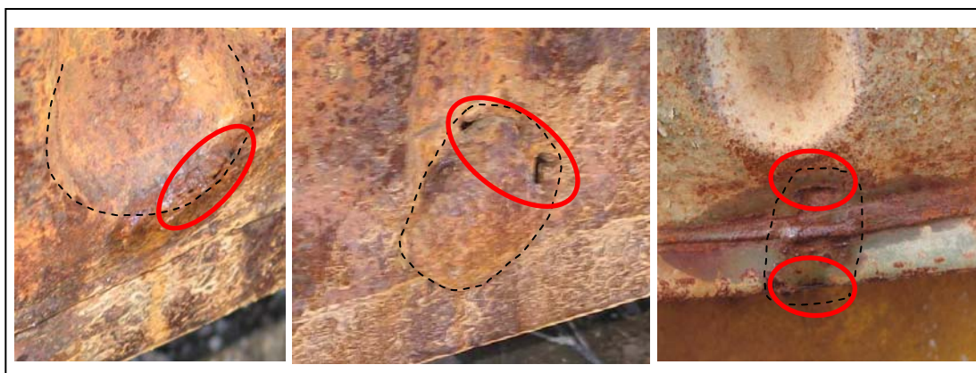
Kuva 21. Vanhoja paikkauksia, joissa on reikiä. Paikkojen koko on 5–10 cm. Kuvattu 5.8. Kaksi vasemmanpuoleista kuvaa esittävät reikiä Q. (peräjakson vasemmanpuoleisen ponttoniyksikön keskiponttonin taaempi tankki, vasen pitkittäislaipio).
