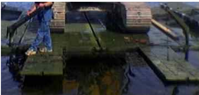
Kuva 10. Yksi lauttajakso kuormattuna kaivinkoneella. Osa yrityksen toimittamasta kuvasta.
