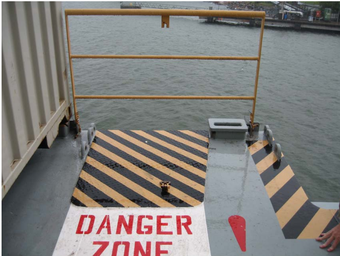
Kuva 8. Kaide pystyyn nostettuna aluksen BB-puoli.
