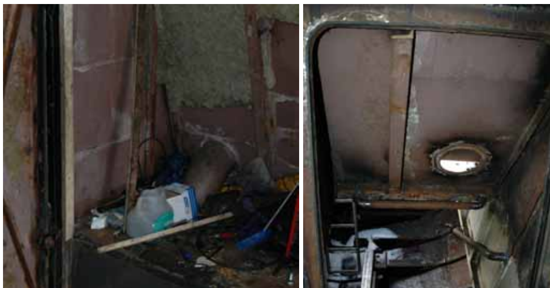
Kuvat 13a ja 13b. Konehuoneen ilmanottoaukot oikealla (vasen kuva, alaskäynti konehuoneeseen) ja vasemmalla (oikea kuva, valmiissa aluksessa ilmanottoputki jää laatikoston sisään). Reiän halkaisija on noin 13 cm ja sen alareunan etäisyys kannesta on noin 65 cm. Kuvat on otettu ROLLEn peruskorjauksen aikana keväällä 2005.
