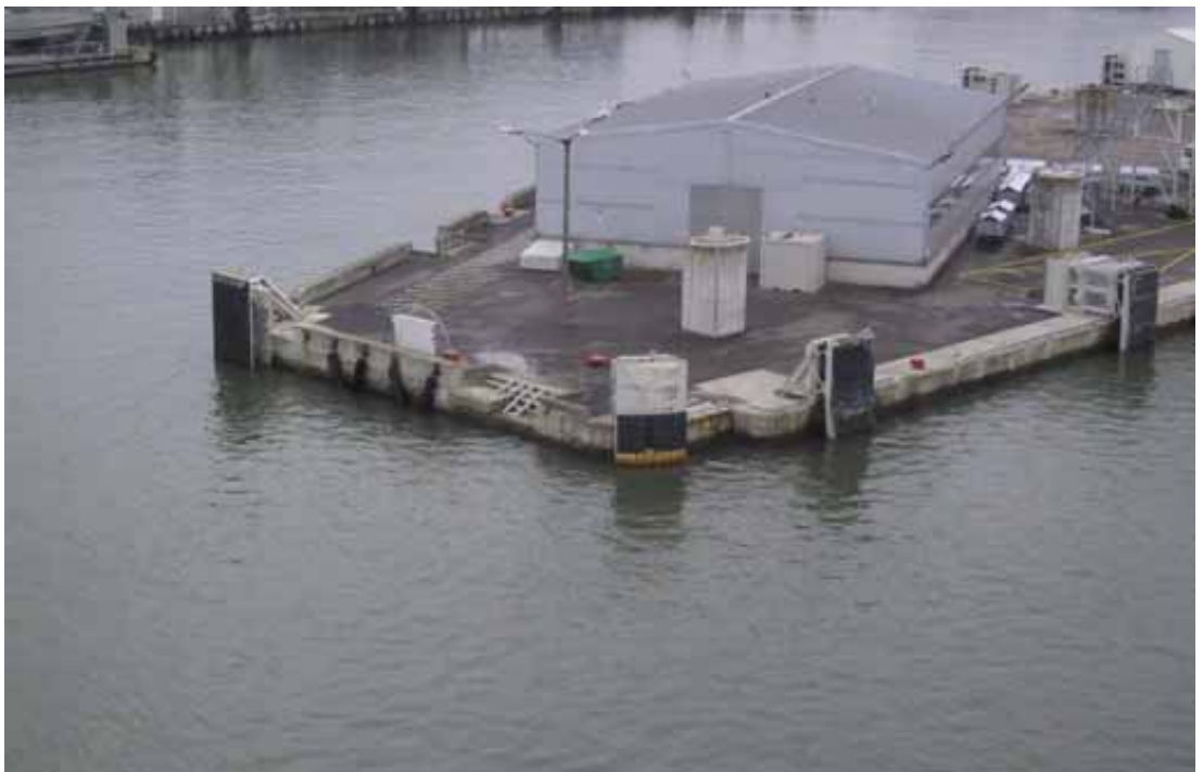
Kuva L4b. Laiturin kulmassa on "fenderi" johon voi nojata käännettäessä alus laiturin suuntaiseksi.
