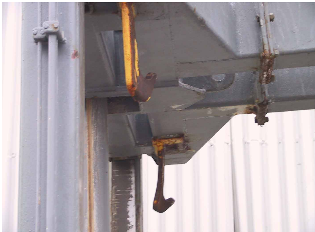
Kuva 6. Vääntyneet nostokoukut.
