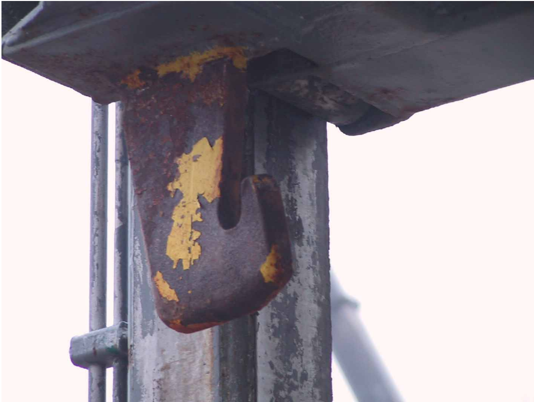
Kuva 7. Yksityiskohta nostokoukusta.
