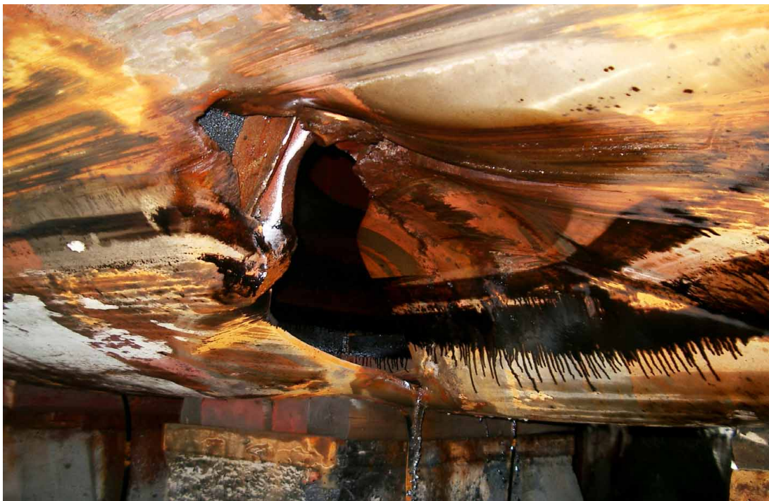
Kuva 13. GLOBAL FREIGHTERin pohjan suurin vaurio.
