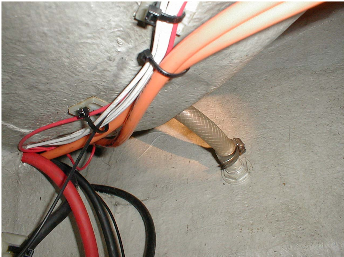
KUVA 8. Putki konehuoneeseen BB
