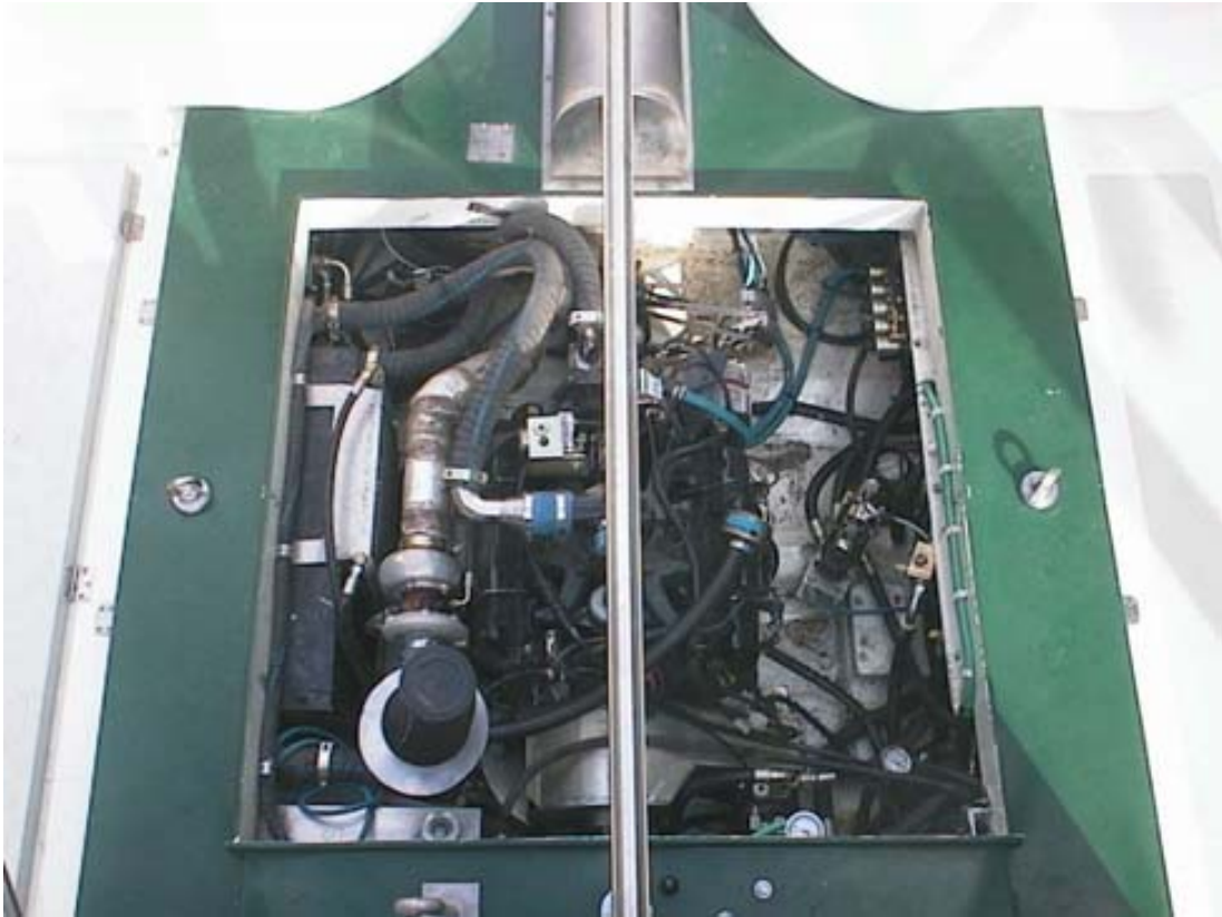
Kuva 7. Kone ja konetila konekoppa poistettuna. Kuvattu ohjaamon katolta aluksen perään päin. Kuvattu ennen viimeistä muutostyötä.
