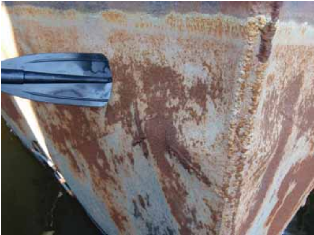
Kuva 5. Laidoituksen repeämien korjaukset.
