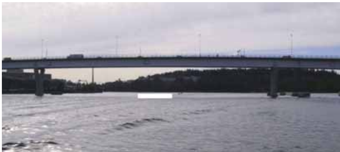
Kuva 16. Yhdistelmän kulku maantiesillan ali. Kuvaan on merkitty yhdistelmän leveyttä 18 m vastaavalla mittatikulla.
