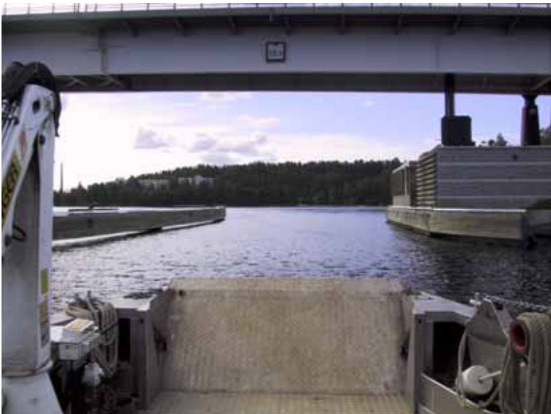
Kuva 11. Tulo maantiesillan johteisiin.
