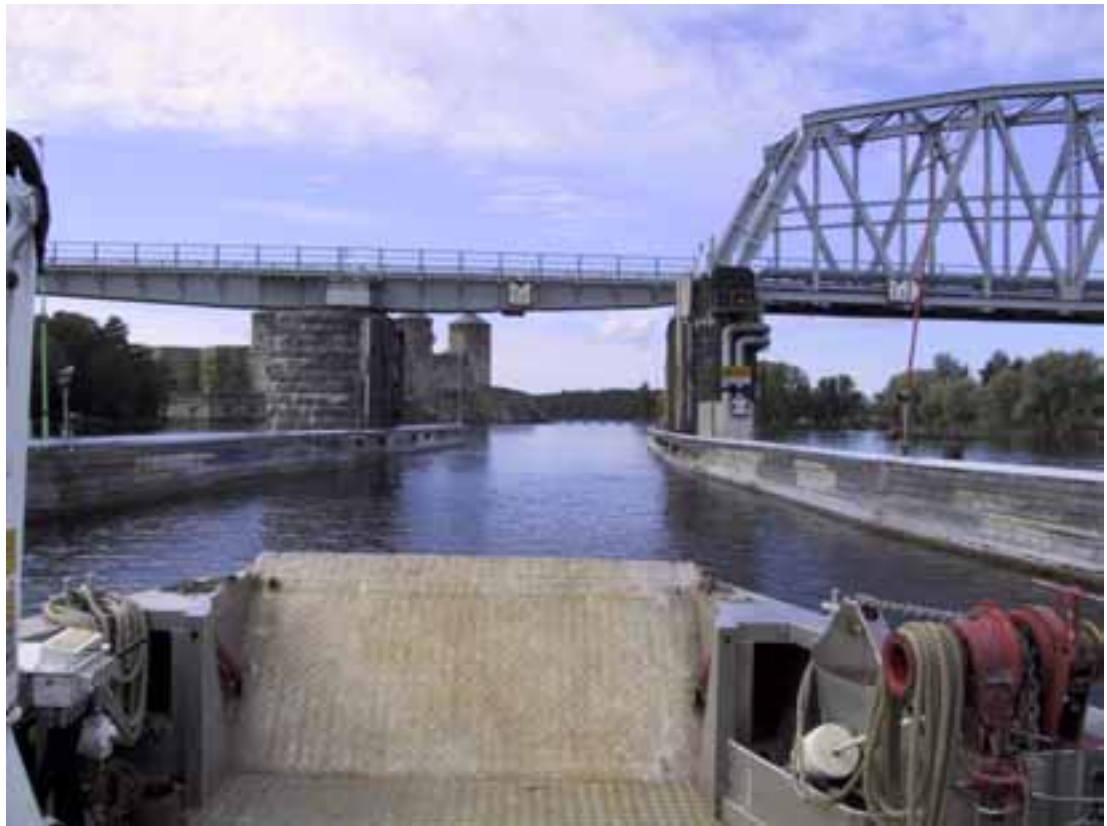
Kuva 12. Tulo rautatiesillan johteisiin.
