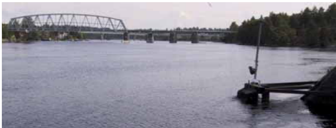
Kuva 19. Linnan kalliossa oleva ohjuri, johon yhdistelmä törmäsi. Katsottuna etelästä taustalla on rautatiesilta.
