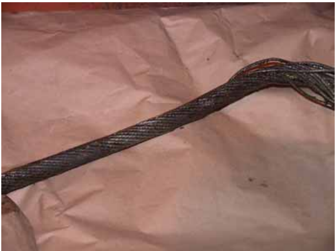
Kuva 7. Nostovaijeri. Keskellä kuvaa näkyy kohta, jossa puristusliitoksen holkki oli.
