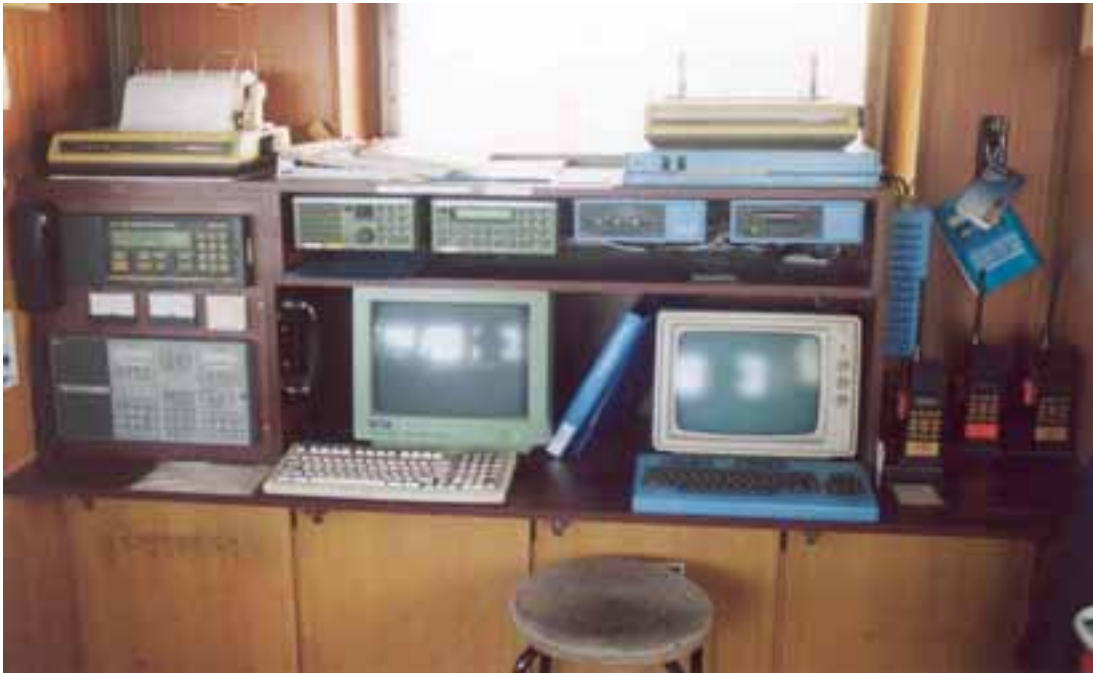
Kuva 5. TRADENin komentosillan radiolaitteet.
