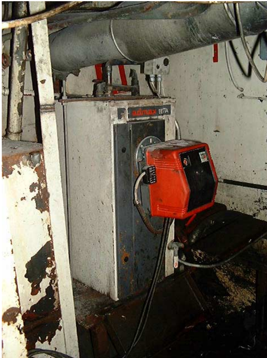
Kuva 12. RANDÖn lämpökattilan savuhormin konehuoneessa ollut eristetty, vaakasuora osa.
