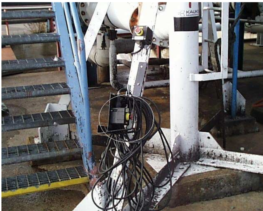
Kuva 14 Kaukomarkkinoiden jatkokaapelilla varustettu lastauspumpun hätäpysäytysnappi (regastettu) joka kiinnitetään aluksen reelinkiin. Asennettu Crystal Rubinon ylllastauksen jälkeen.
