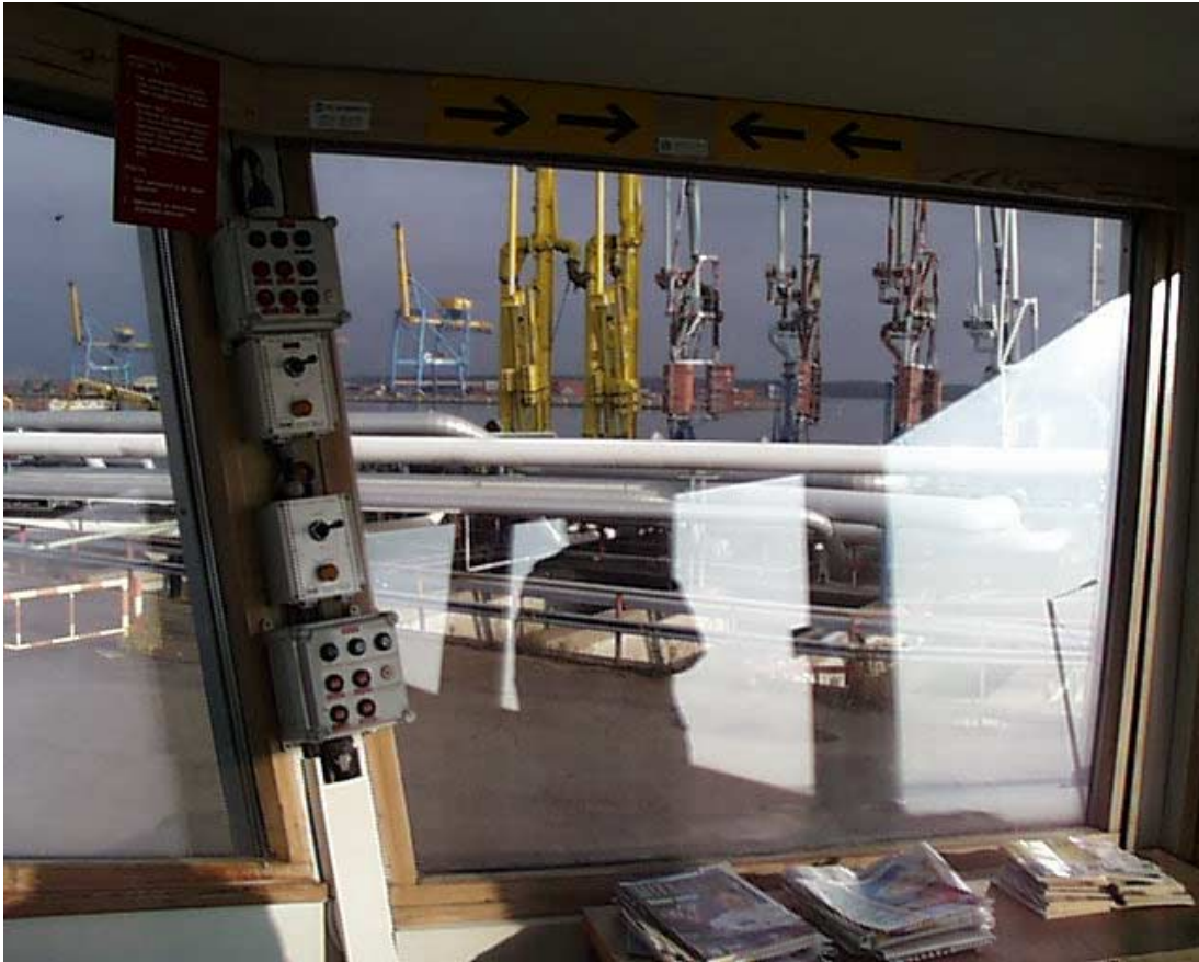
Kuva 13 Laiturivalvomosta näkee putkistojen yli alukselle rajoitetusti. Kuvan vasemmassa laidassa palopumppujen kaukokäynnistys ja palotykkien –ohjaus
