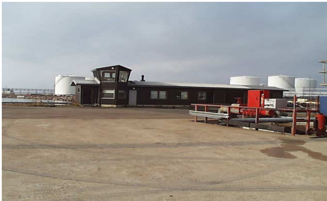
Kuva 12 Lastausta valvovan terminaalin edustajan valvomo rakennuksen toisessa kerroksessa. Alempi huone on satamavalvojan käytössä tarvittaessa. Laituri on varustettu öljyntorjuntakalustolla (öljypuomit sekä vene), jotka eivät näy kuvassa.
