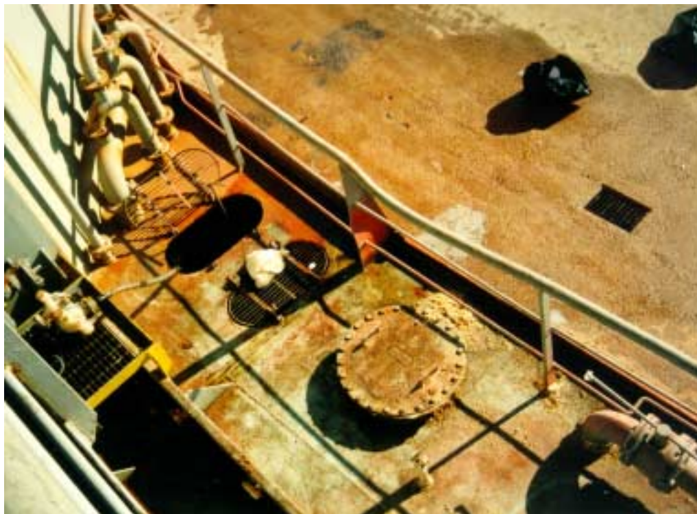
Kuva 7 Ylivuotokaivo aluksen peräosassa
