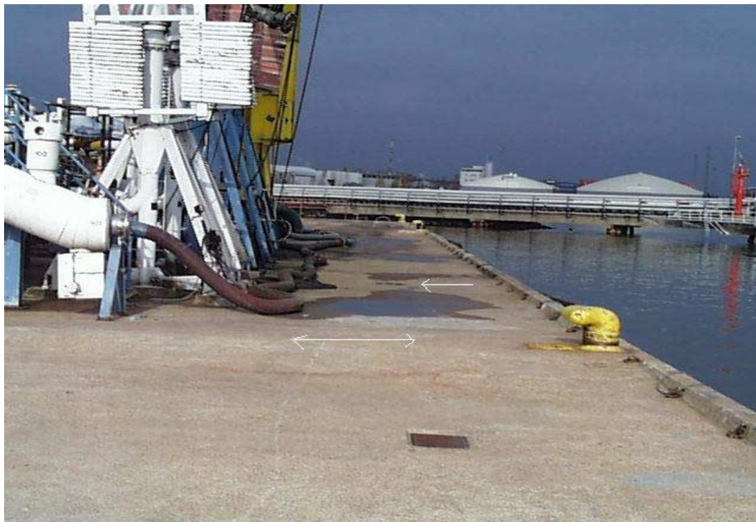
Kuva 5 Ylempi yksisuuntainen nuoli osoittaa varsinaisen lastausalueen kohdalla olevaa viemäriä, joka johtaa laiturikaivoon. Kaksisuuntainen nuoli osoittaa koroketta, joka eristää varsinaisen lastausalueen muusta laiturista
