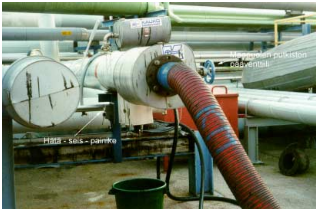
Kuva 2 Lastausletku, kiinnitys laiturilla, pääventtiili ja hätäpysäytyspainike. Huomaa myös kiinnityslaipan puutteellinen kiinnitys.
