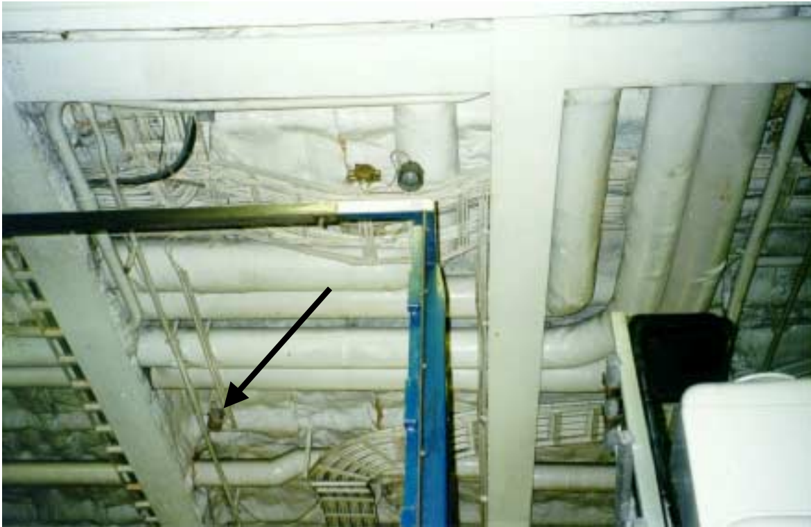
Kuva 3a. Vaurioitumaton kansi palopaikan yläpuolella. Nuolella on merkitty savuilmaisin rekan yläpuolella.
