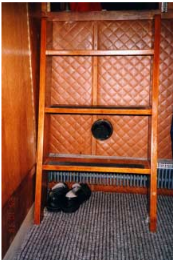
Kuva 15. Lämmityslaitteen läpivienti keulasalongin ja konehuoneen välisessä laipiossa.
