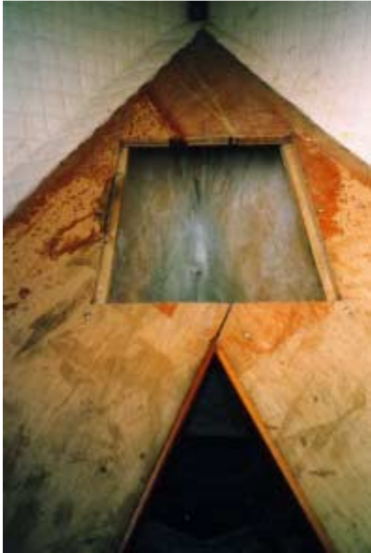
Kuva 10. Keulapiikin kanteen tehty aukko.
