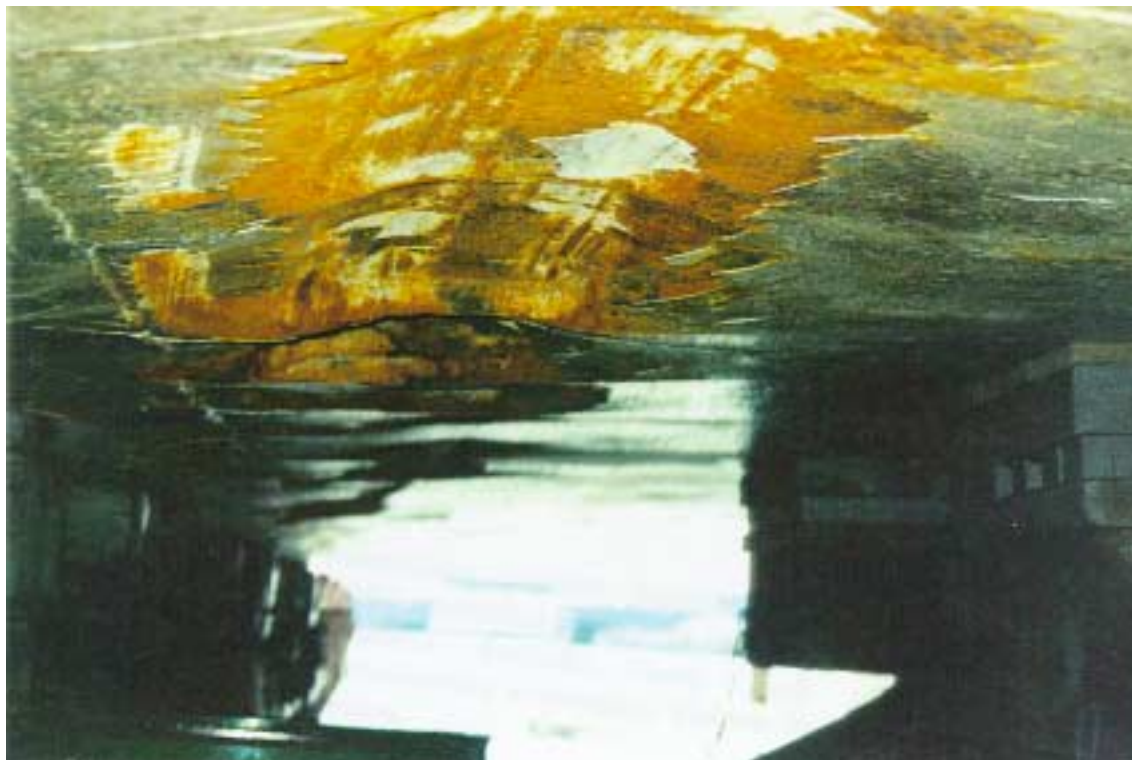
Kuva 5. M/S KATARINAn pohjavaurioita.
