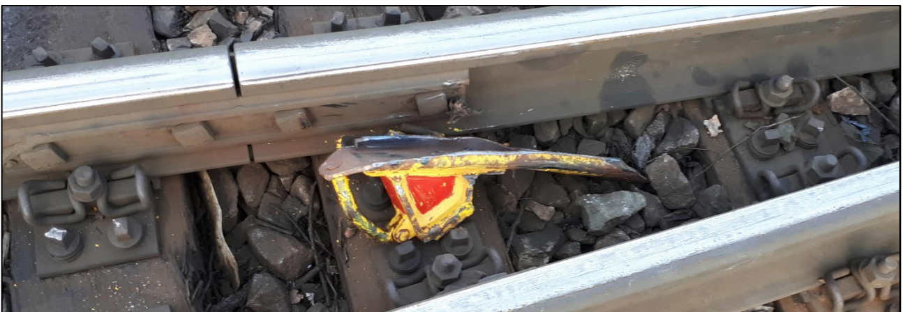
Kuva 4. Lähikuva pysäytyskengästä vaihteessa V512. (Kuva: Poliisi)
