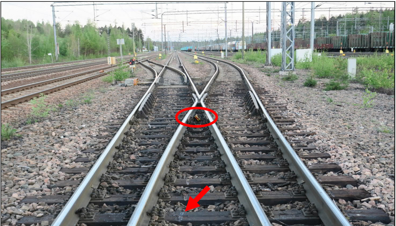
Kuva 3. Suistuminen tapahtui vaihteessa V512. Juna tuli vaihteeseen oikeanpuoleiselta raiteelta. Vaunun vaihteessa suistanut pysäytyskenkä on jäänyt vaihteen ristikkoon. Suistumisjäljet näkyvät selvästi puisissa ratapölkkyissä. (Kuva: Poliisi)
