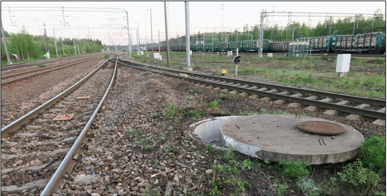
Kuva 5. Kuva vaihteen V510 pohjoispuolelta. Vaunun takatelin jäljet näkyvät sepelissä. Betoninen kaivon kansi on siirtynyt vaunun osuessa siihen. (Kuva: Poliisi)
