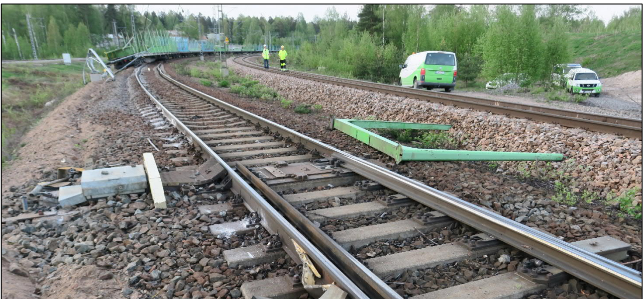
Kuva 6. Vaunusta irronnut pankko ratapenkereellä. Kiskojen vasemmalla puolella suistuneen vaunun rikkomia radan laitteita. (Kuva: Poliisi)
