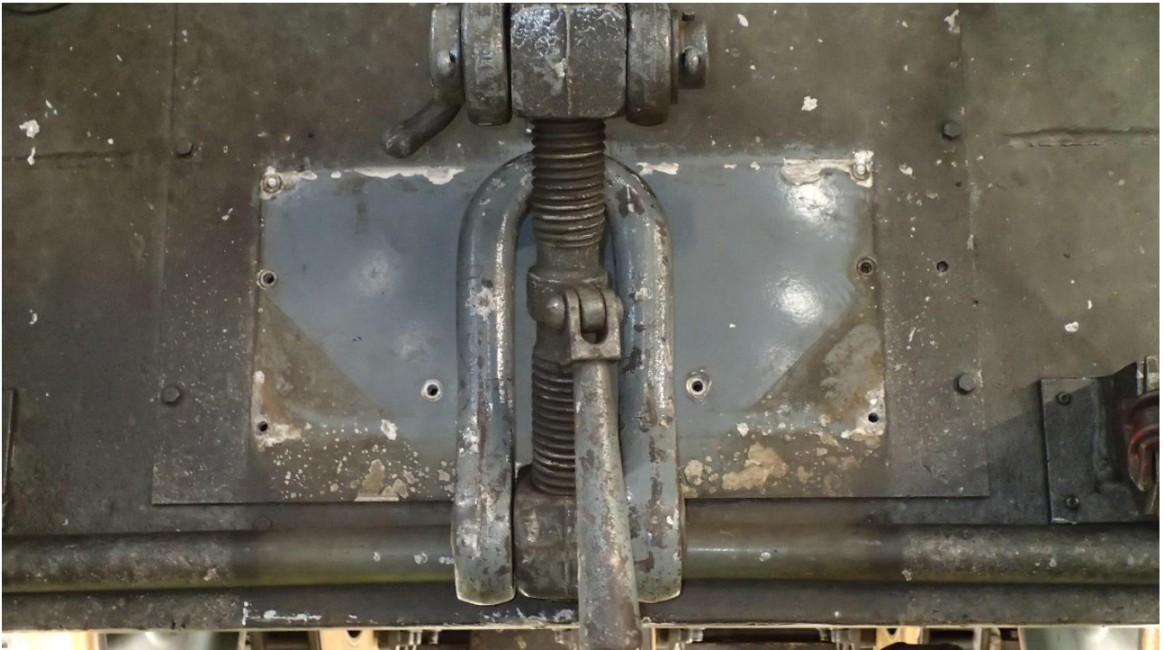
Kuva 1. Vaunun Ed 28007 pääsystä irronneen suojalevyn kohta ruuvikytkimen takana. Ruuvikytkin on kuvassa nostettu ripustuskoukkuunsa. (Kuva: OTKES)
