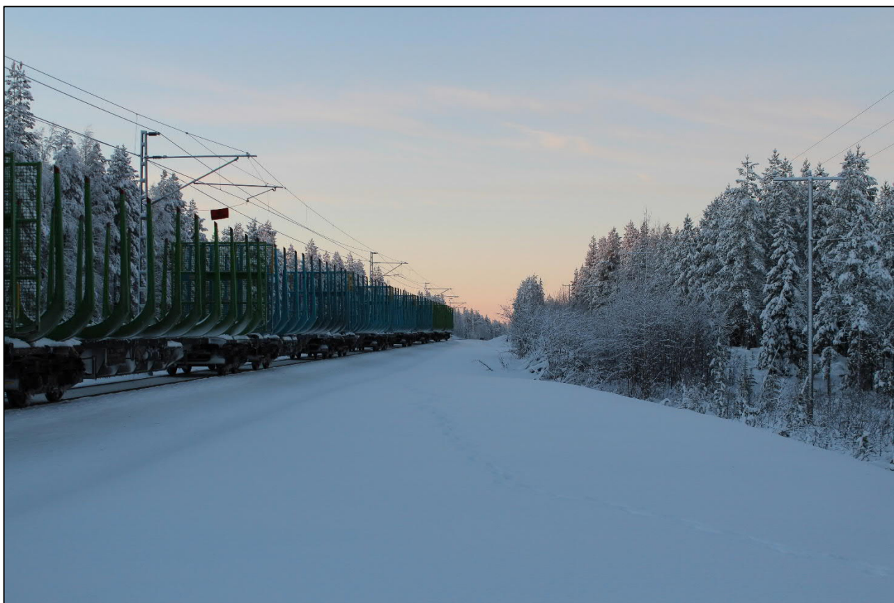
Kuva 22. Tasoristeyksen näkemä auton tulosuunnasta (pohjoisesta) oikealle junan tulosuuntaan (länteen) 8 metrin päässä kiskosta, kuvattu 12.12.2018 (KUVA: OTKES)
