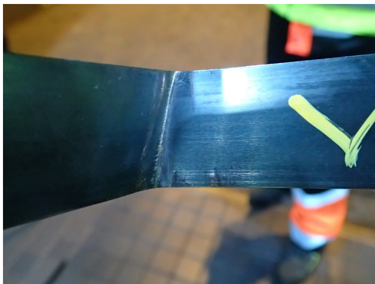
Kuva 13. Rainakelan, josta raina irtosi ja putosi, silmävanne oli ollut vinossa noin 5 astetta kulman taitoksen perusteella. (Kuva: OTKES)
