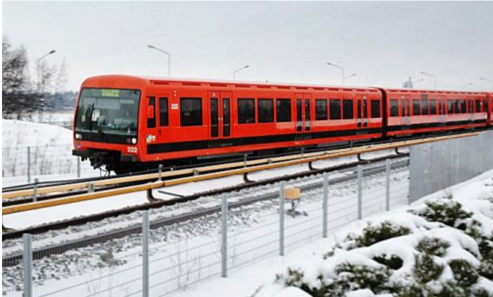
Kuva 13. M200-sarjan metrojuna. (Kuva: HKL)
