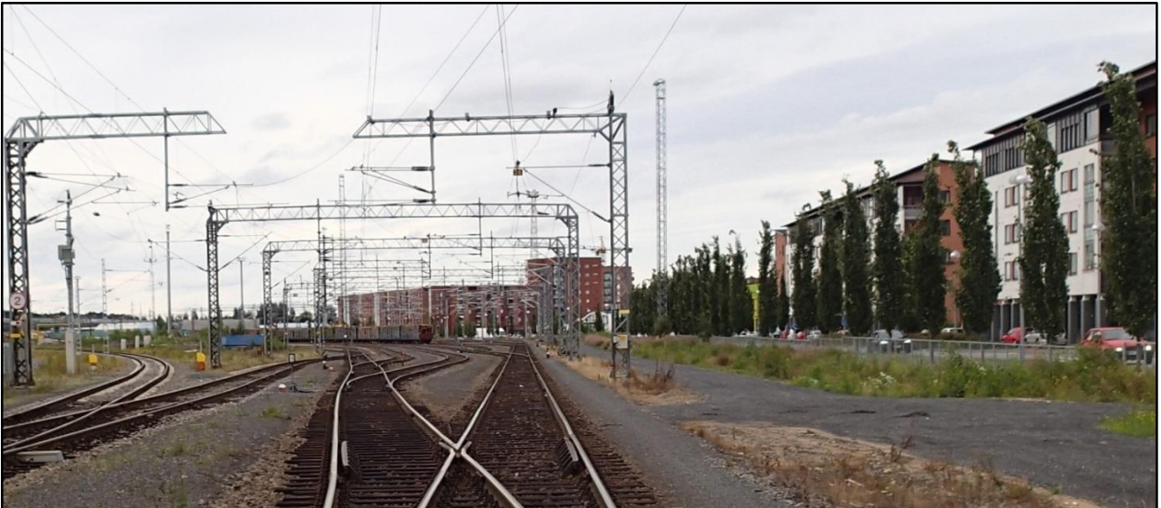
Kuva 7. Näkymä junan tulosuunnasta kohti onnettomuuspaikkaa. Kuvassa oikealla auton kääntöpaikka, jossa vaihdemies käänsi autonsa ja tarkisti vaihteen V101 asennon. (Kuva: OTKES)
