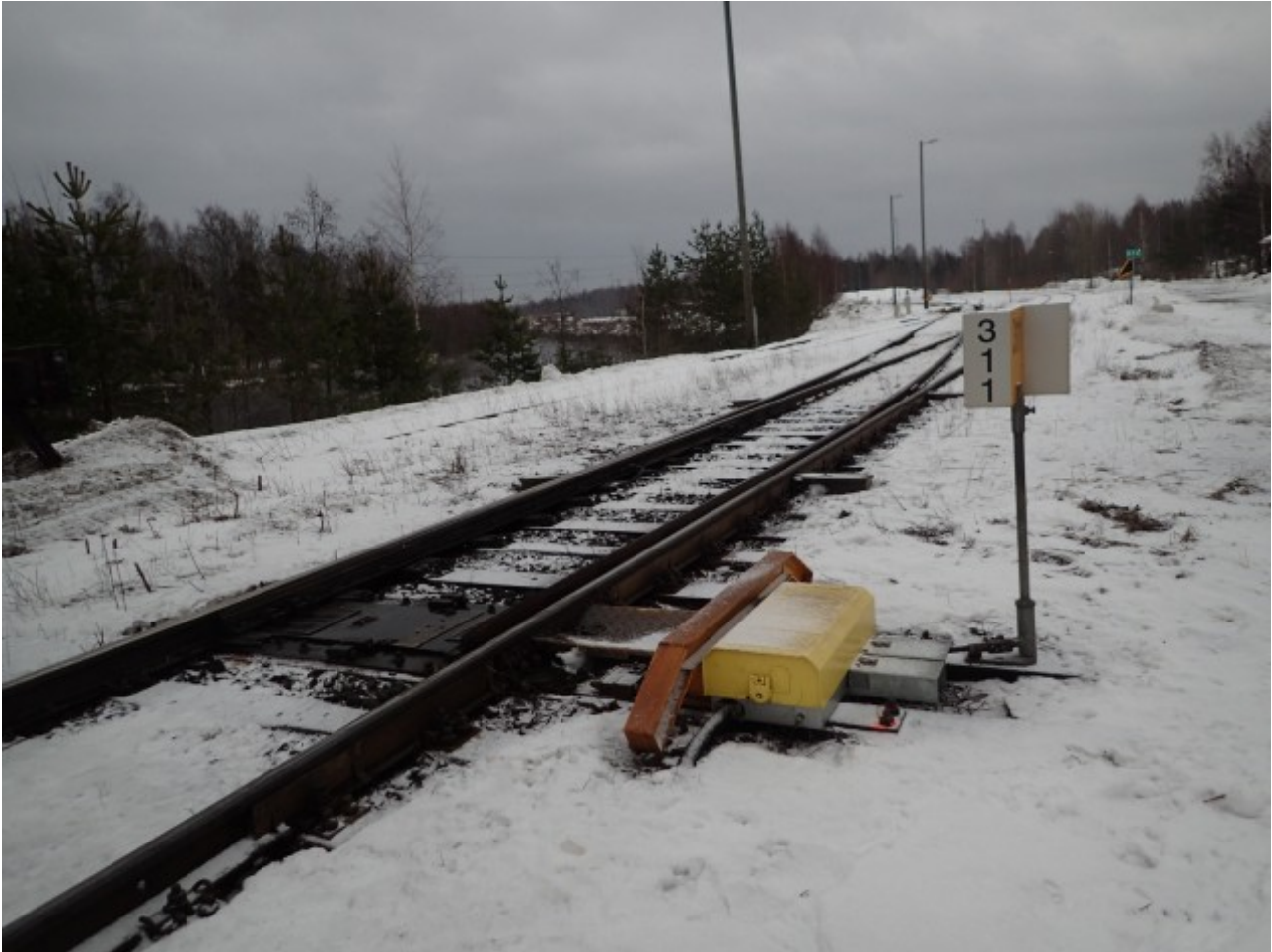
Kuva 2. Näkymä vaihteelta V311 junan tulosuuntaan (Kuva: OTKES).
