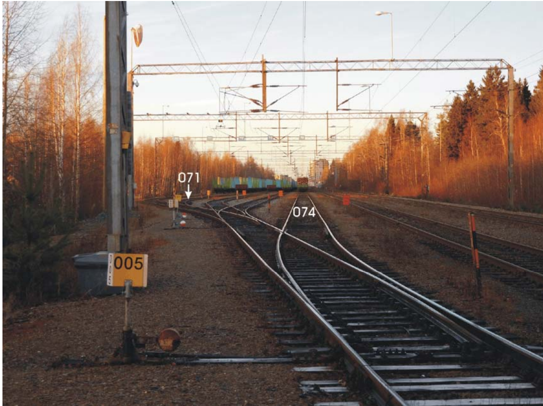
Kuva 5. Vaihde V005 on kuvassa vaihdekopin suunnasta Sulkulahden ratapihalle päin. Vaihde on käännettynä samaan asentoon, kohti raidetta 074, kuin se oli tutkitavan tapauksen yhteydessä. Raide 071 on toinen vasemmalta.
