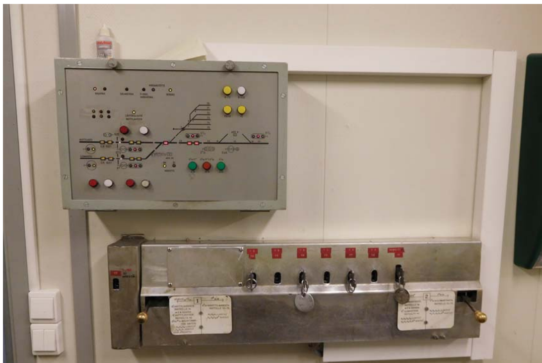
Kuva 4. Asetinlaite VI:n vaihde- ja opastinturvalaitoksen käyttötaulu. Alempi osa on turvavaihteiden avaintaulu johon avaimet tuodaan vaihteiden käynnön jälkeen. Tämän taulun oikean reunan kulkutiesalvalla turvataan kulkutietä Ilomantsin suuntaan/suunnasta ja vasemman reunan kulkutiesalvalla Niittylahden suuntaan/suunnasta. Ylempi osa on opastimien ohjaustaulu.
