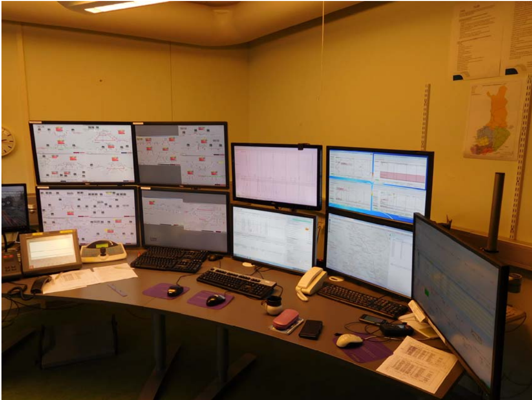
Kuva 3. Joensuun liikennepaikan liikenteenohjaajan työpöytä. Vasemmalla kuvassa olevat kaksi alinta näyttöä ovat Joensuun liikennepaikan liikenteenohjaukseen liittyviä. Niiden yläpuolella olevat kaksi näyttöä ovat informatiivisia näyttöjä koskien Karjalan kaukon ja Pielisen kaukon alueita. Työpöydän oikean puoleiset näytöt sisältävät graafista ja numeraalista aikataulutietoa sekä Joensuun liikennepaikan että edellä mainittujen kauko-ohjausalueitten osalta. Kuvan aivan vasemmanpuoleisessa reunassa on myös ratapihakameran näyttö. Kameran kuvaa ei tallenneta.
