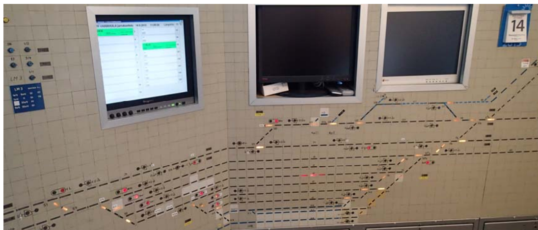
Kuva 5. Vainikkalan ratapihan länsipään raiteisto releasetinlaitteen ilmaisintaulussa.
