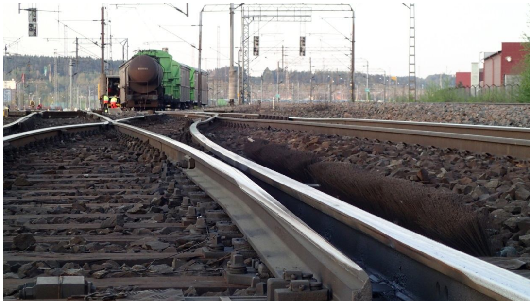
Kuva 3. Vaihteen V805 risteyksen kohdalla oli radassa selkeä painuma.
