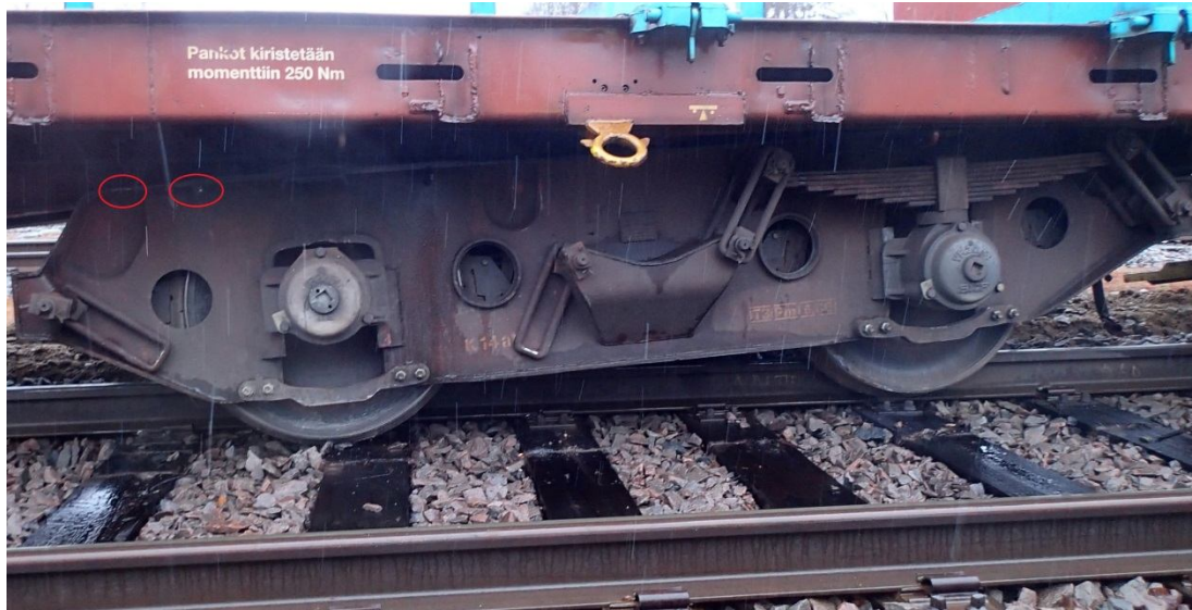
Kuva 5. Suistuneen toiseksi viimeisen vaunun etutelin oikea puoli. Taaemman pyöräkerran lehtijousi oli pudonnut. Punaisella merkitystä kohdista löytyi hankaumajälkiä, jotka ovat syntyneet lehtijousen osuessa telin rakenteisiin.
