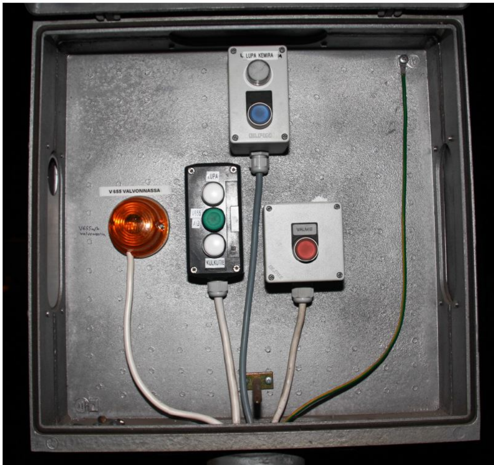
Kuva 1. Kemira turvalaitteen käyttökytkimet ja ilmaisimet
