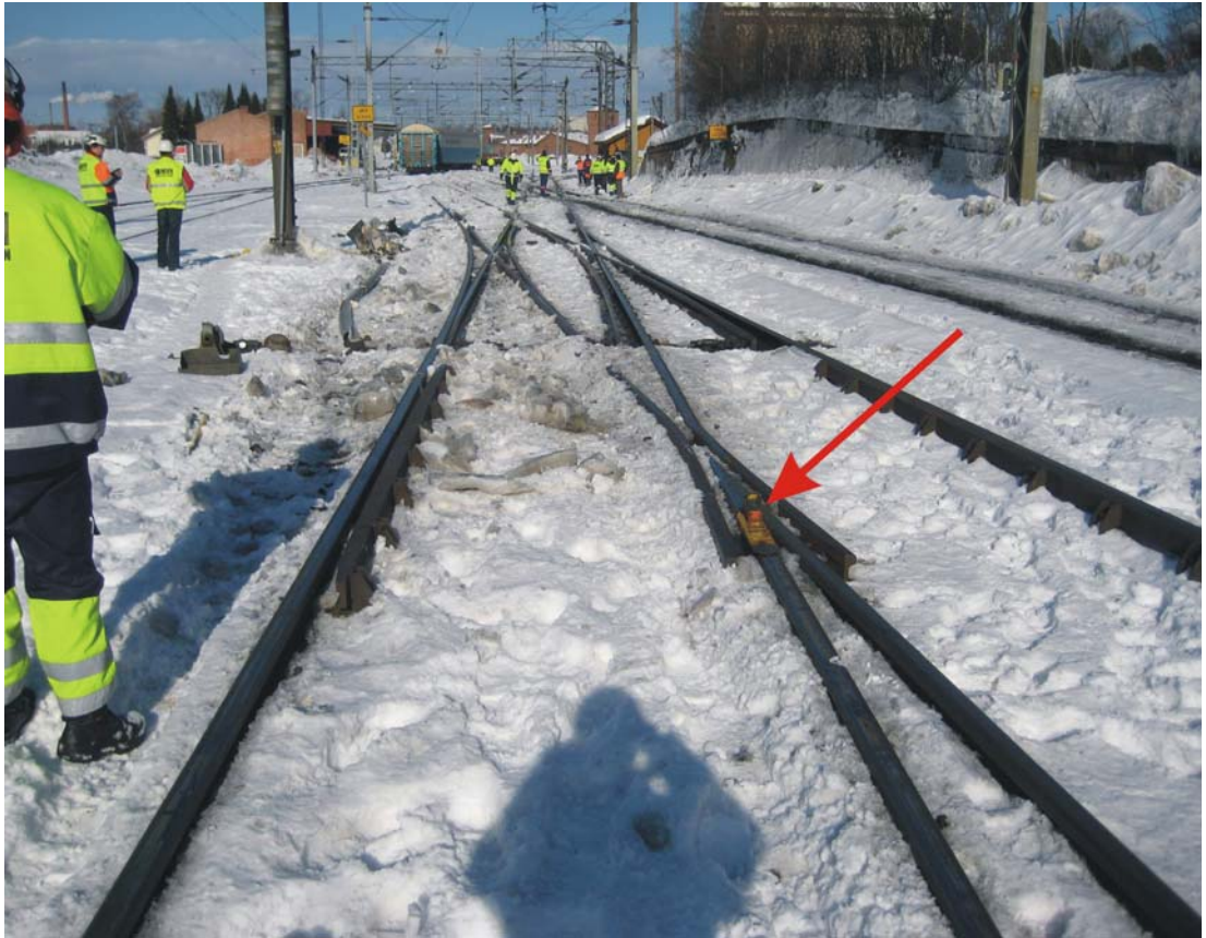
Kuva 2. Vaihteen V041 vaihderistikkoon kiilautunut pysäytyskenkä on merkitty punaisella nuolella. (Kuva: VR Cargo)
