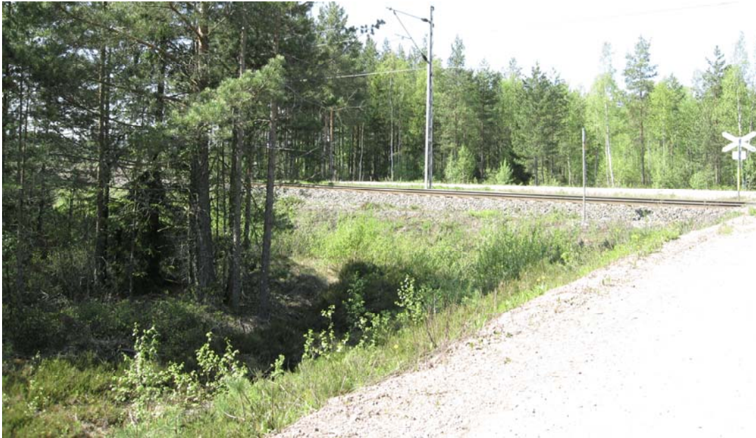
Kuva 6. Näkyvyys radalle junan tulosuuntaan 30 metriä ennen kiskoja.
