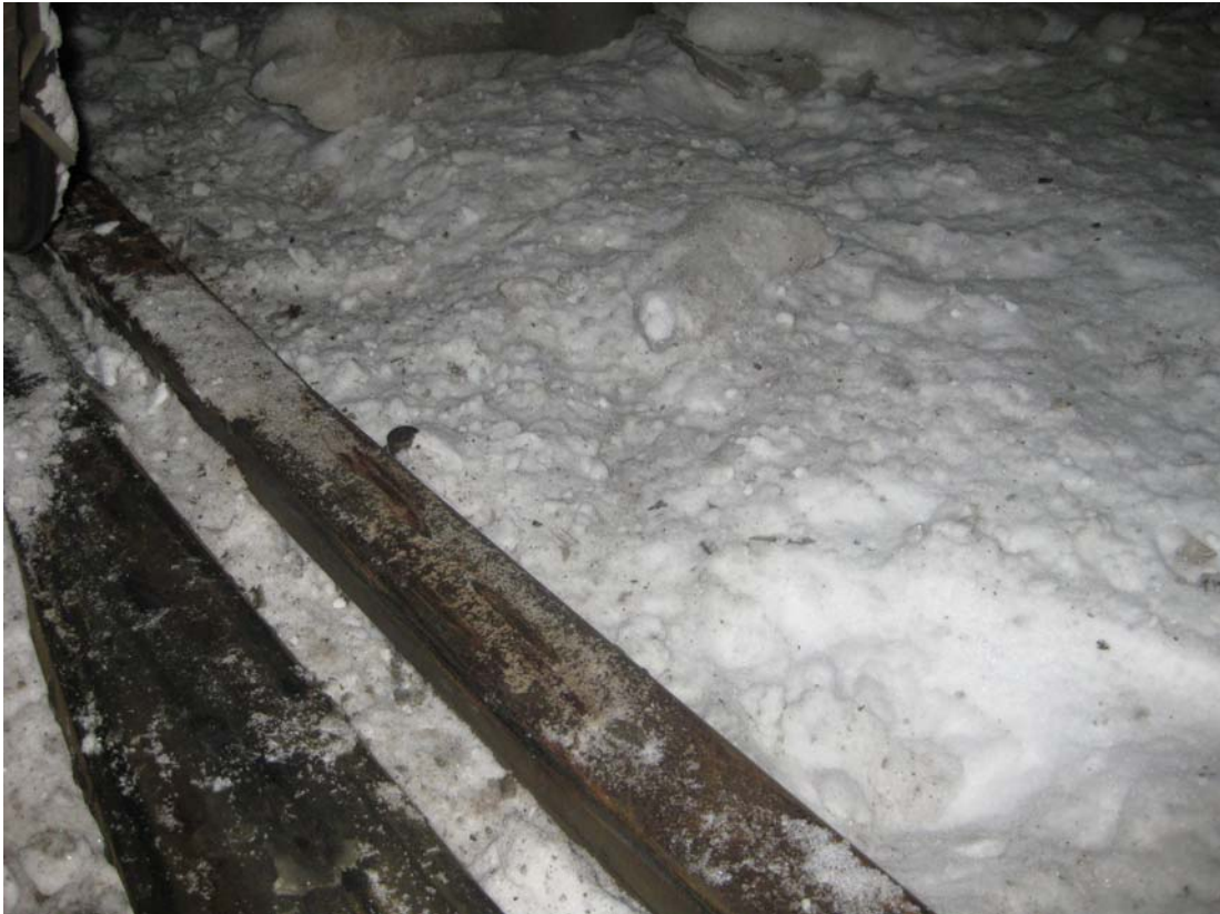
Kuva 5. Pyöränlaippojen tekemiä jälkiä siipikiskossa.
