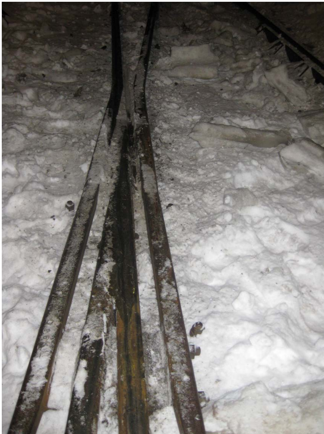
Kuva 4. Risteyksen kärjen ja siipikiskon väliset laippaurat olivat täynnä teräsjäätä, jonka kohdalla vaunujen pyörät kulkivat laippojen varassa.
