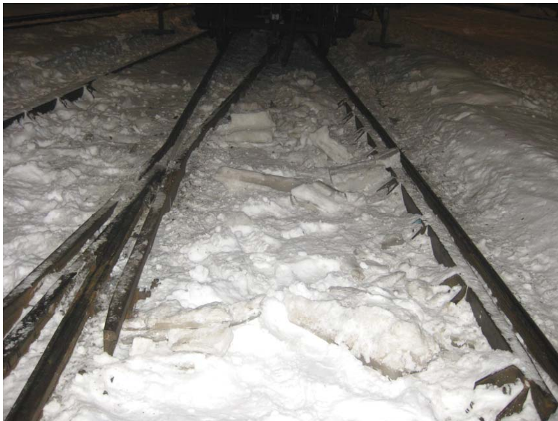
Kuva 6. Vaihteen V662 risteuksen kohdalla ja sen läheisyydessä oli paljon lumi- ja jäälohkareita.
