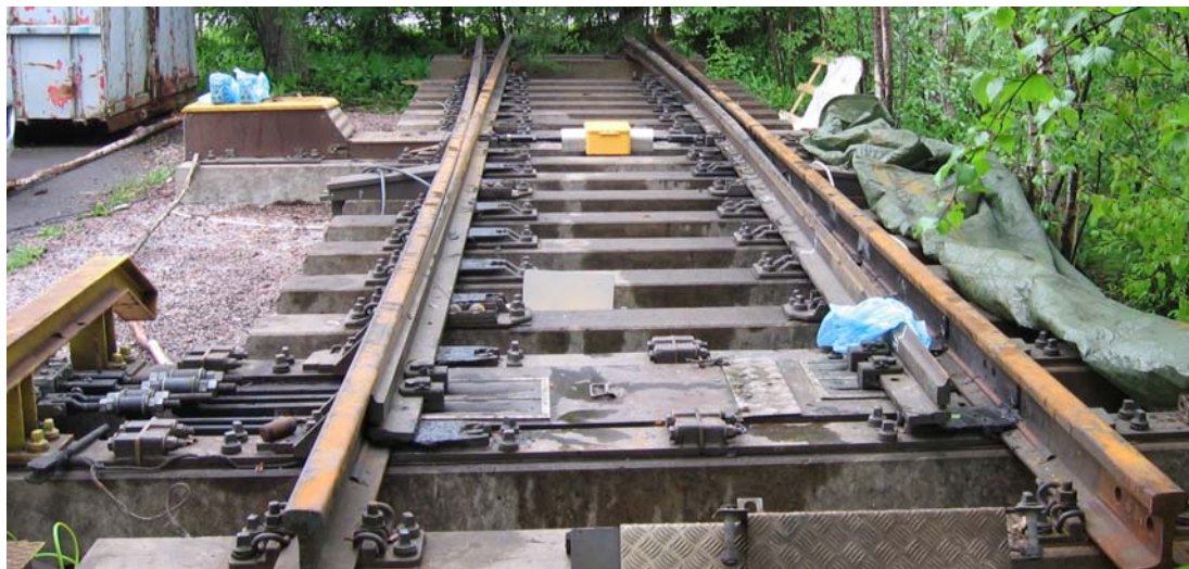
Kuva 14. Vaihte siirrettynä tutkimuspaikalle tarkastuksia ja testauksia varten. Vaihte käännettynä asentoon, jossa se oli junan saapuessa vaihteelle.
