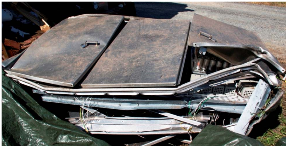
Kuva 19 Tuhoutunut turvalaitekaappi K266.
