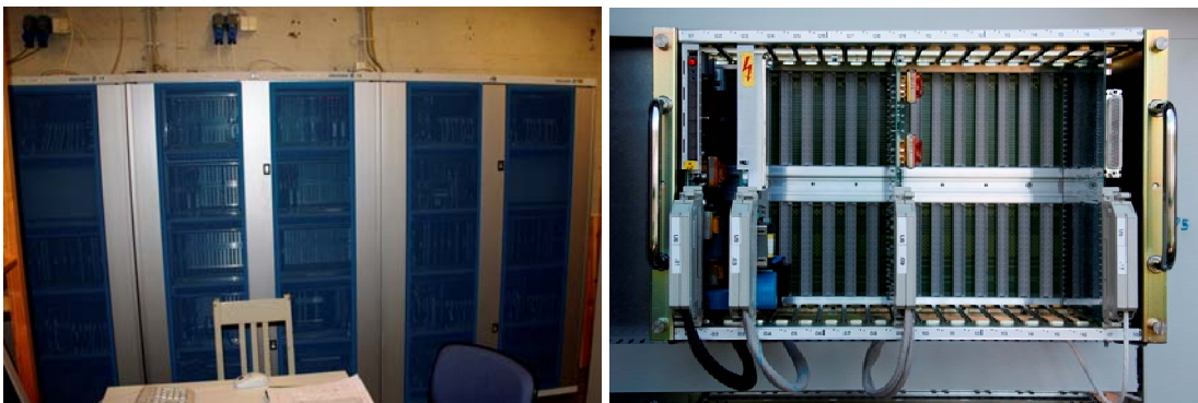
Kuva 12. Vasemmalla Toijalan asetinlaitteen kaappeja laitetilassa. Oikealla ratapihalla olevassa laitekaapissa oleva vaihteen ohjausyksikkö (asetusosa).
